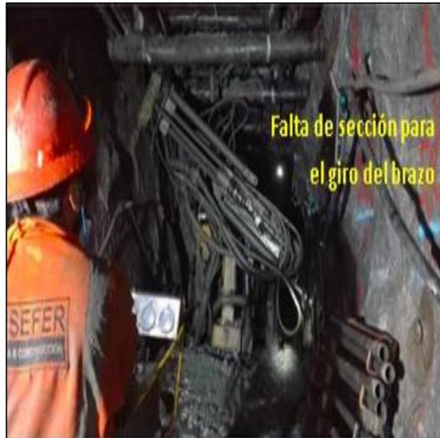
**Figura 27.** Mal posicionamiento y área angosta de la labor.
