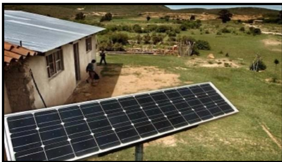
Figura N° 8: Electrificación rural en las zonas del Perú
