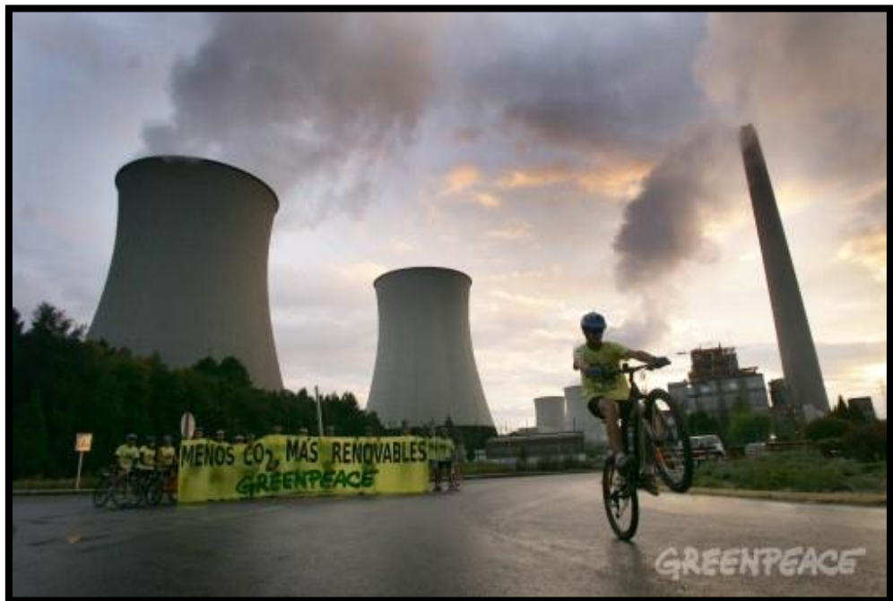
Figura N° 5: Central eléctrica contaminante
