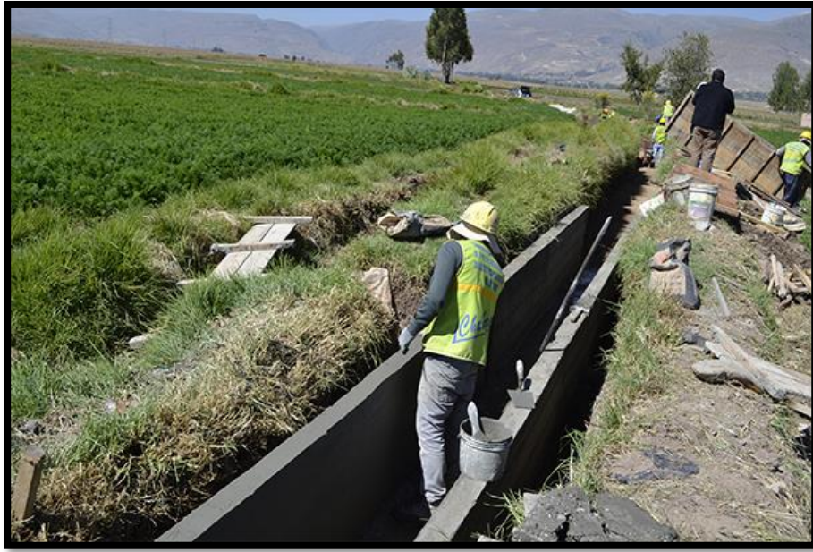
Figura N° 31: Construcción de canales de regadío
