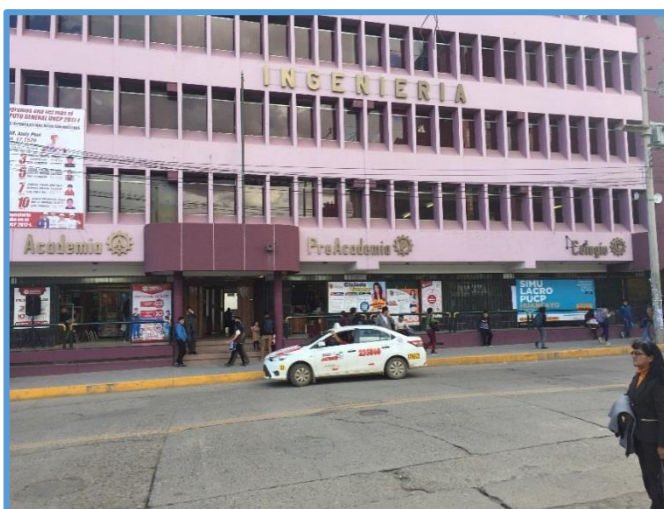
Fotografía 3. Centro de Estudios Ingeniería Fuente: Elaboración propia
