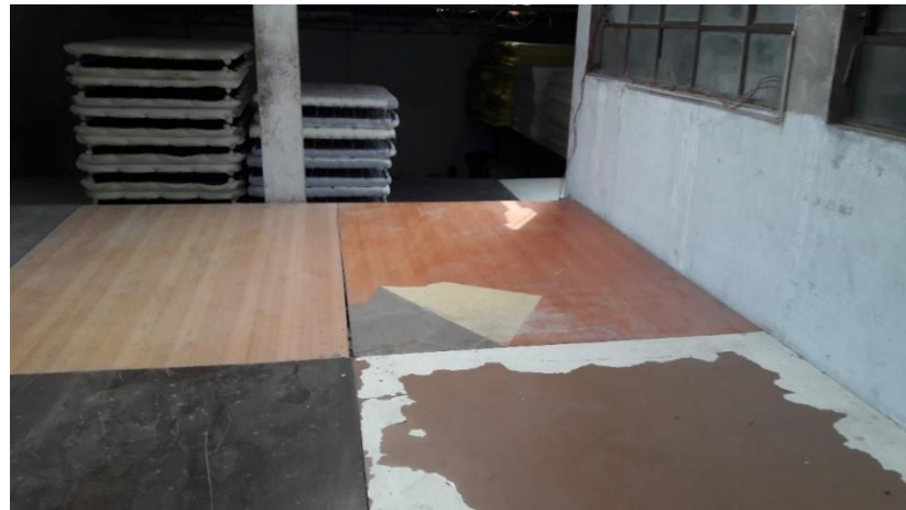
Fotografía 17: Implementación de Ordenar 3 – Antes y Después Fuente: Elaboración Propia – La Empresa
