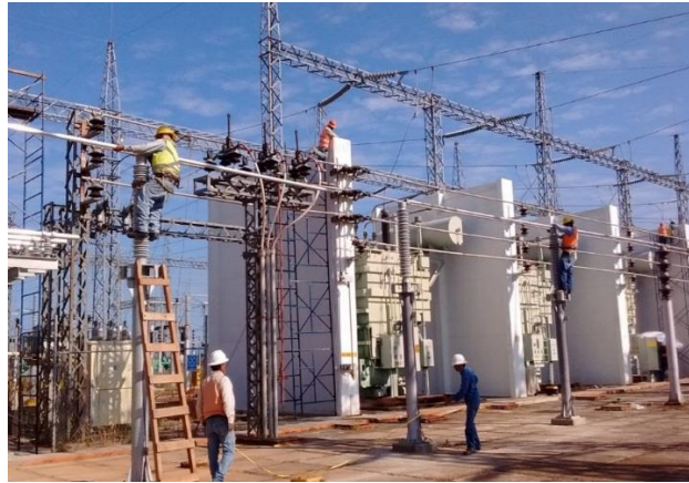
Figura 2. Subestación Eléctrica de potencia
