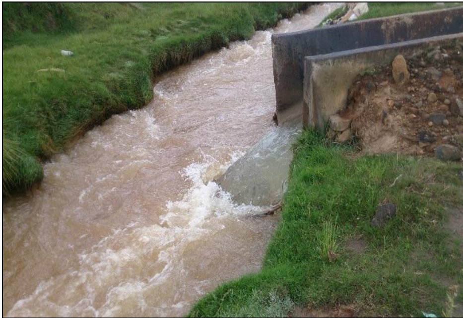
Figura 05: Canal de descarga
