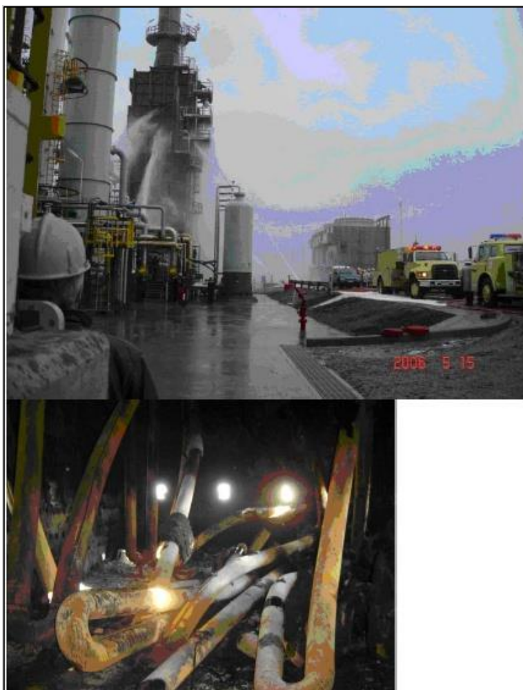
Figura 3. Incendio en un horno de la industria petroquímica por fractura del piñón.
