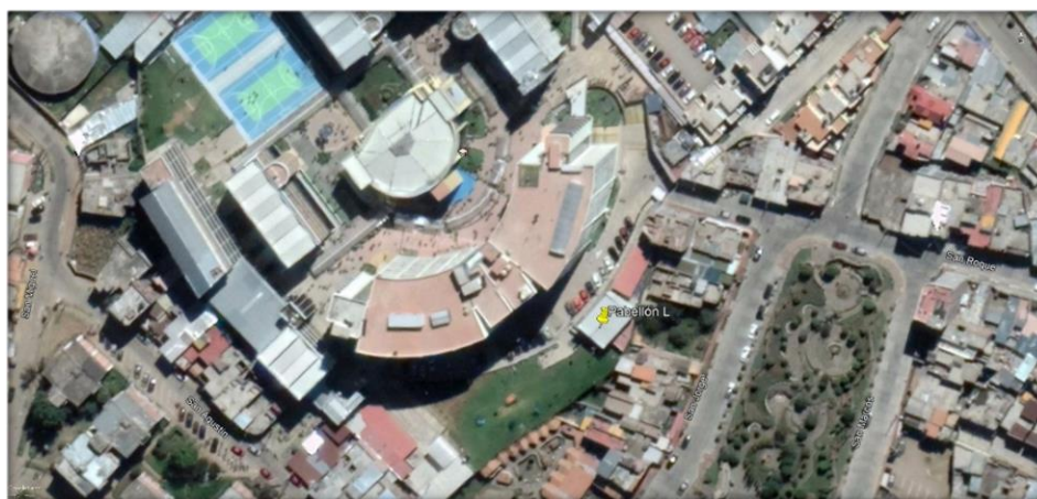
Figura 39. Ubicación del sistema fotovoltaico.
