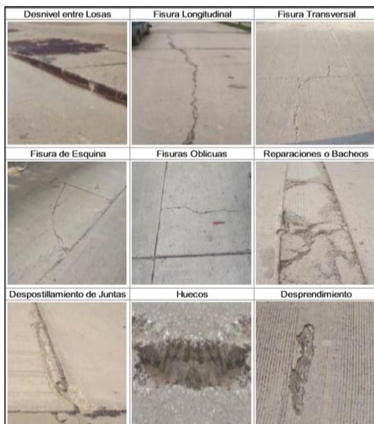
**Figura 2.** Daños en Pavimento rígido
