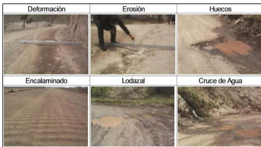
**Figura 4.** Daños en Carreteras no pavimentadas
