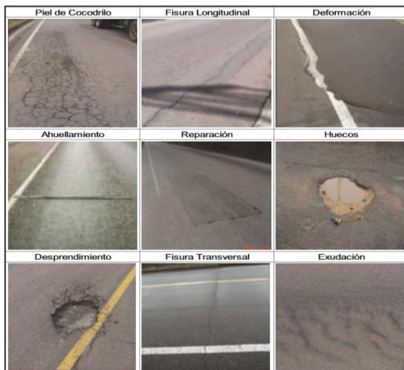
**Figura 3.** Daños en Pavimento flexible
