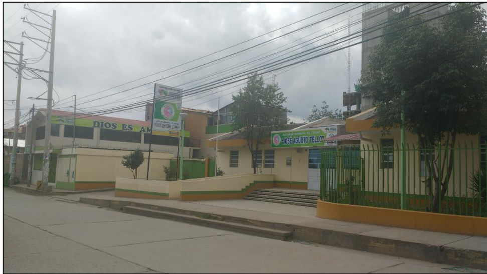
Figura 11: Vista panorámica del hospital Materno infantil “José Augurto Tello” – El Tambo Fuente: Elaboración propia
