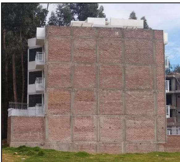
**Fotografía 1. Edificación de 5 niveles con unidades de albañilería artesanal**
