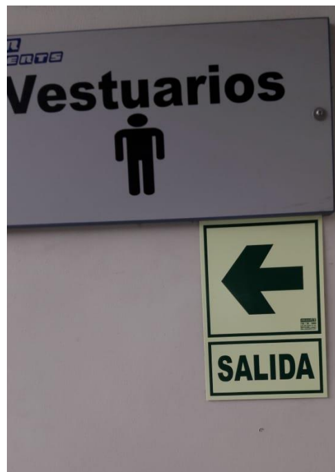
Panel Fotográfico 4: Estado de señalización en el taller
