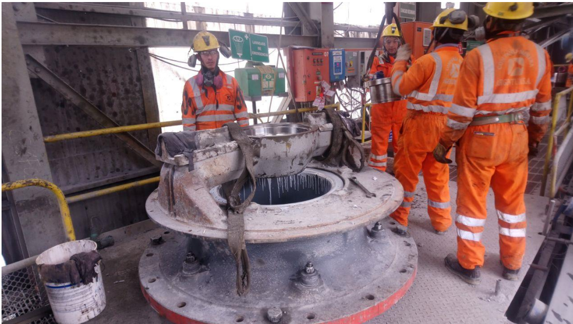
FOTO 4: MANTENIMIENTO DE EQUIPOS EN EL ÁREA DE CHANCADO
