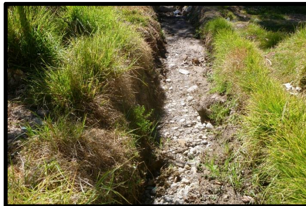
Figura 13. Canal secundario improvisado sin revestimiento Nota. Fuente Elaboración Propia.
