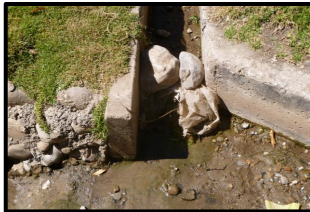
Figura 10. Compuertas De Distribución Del Agua De Riego Con Piedras Y Plásticos Nota. Fuente Elaboración Propia.
