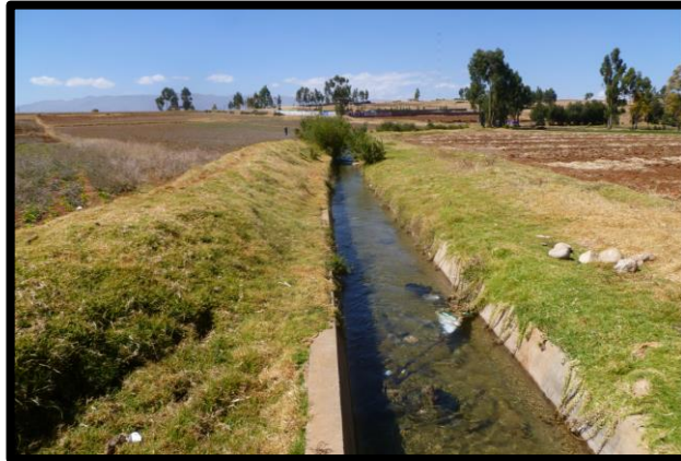
Figura 12. Canales Revestidos Con Sedimentos De Arena En El Fondo Fuente Elaboración Propia.
