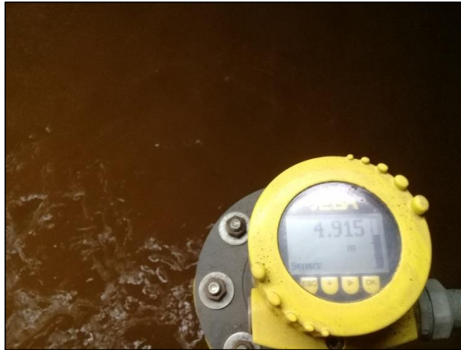
Figura: 18: Montaje E Instalación Sensor De Nivel Fuente: Elaboración propia
