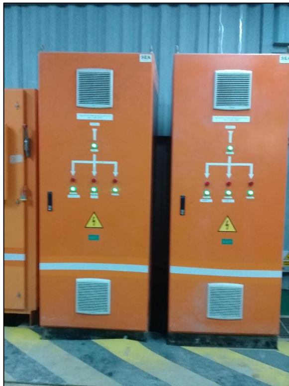
Figura: 07: Montaje Y Conexión De Tableros De Distribución.
