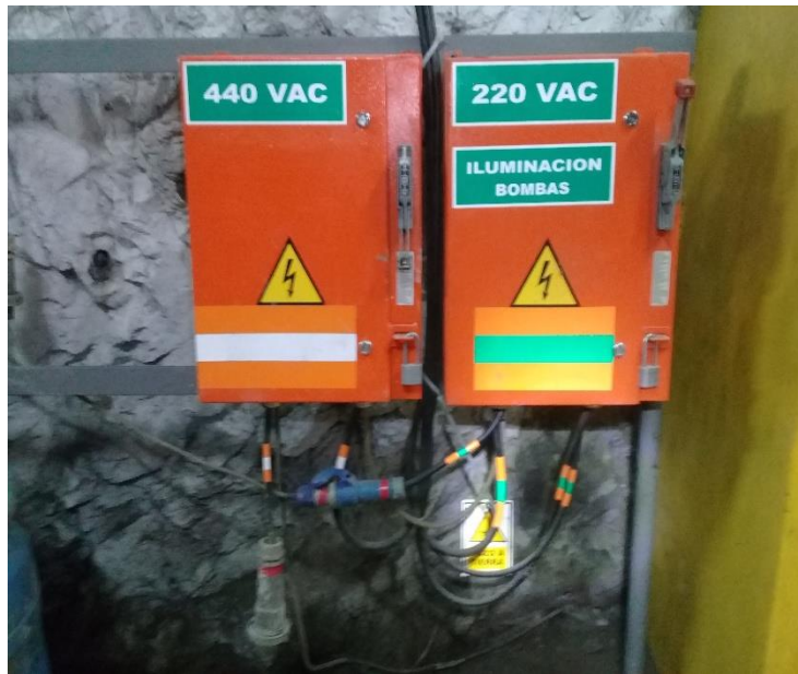
Figura: 11: Montaje E Instalación De Alumbrado Fuente: Elaboración propia
