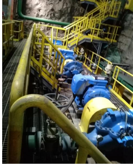
Figura: 09: Montaje Y Conexión De Motores eléctricos.
