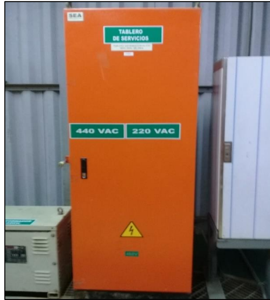
Figura: 10: Montaje Y Conexionado De Tableros De servicio Fuente: Elaboración propia
