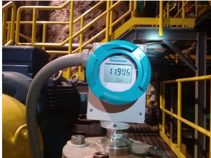
Figura: 17: Montaje E Instalación Sensor De Presión Fuente: Elaboración propia
