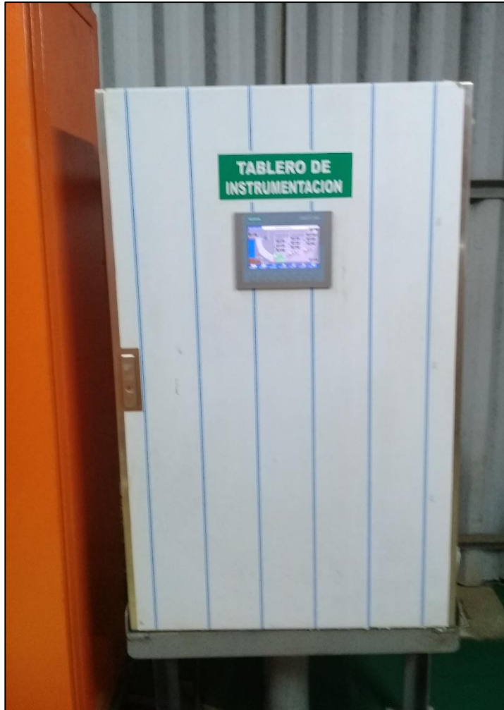
Figura: 14: Montaje E Instalación Tablero Principal De Instrumentación Fuente: Elaboración propia
