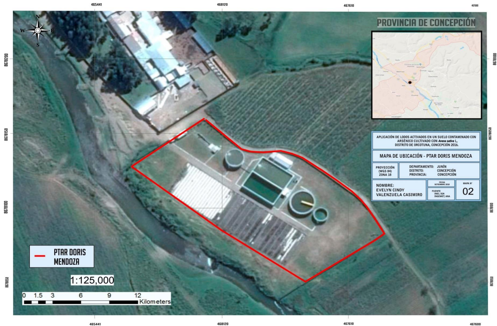
Figura 5. PTAR Concepción “Doris Mendoza” Fuente: elaboración propia
