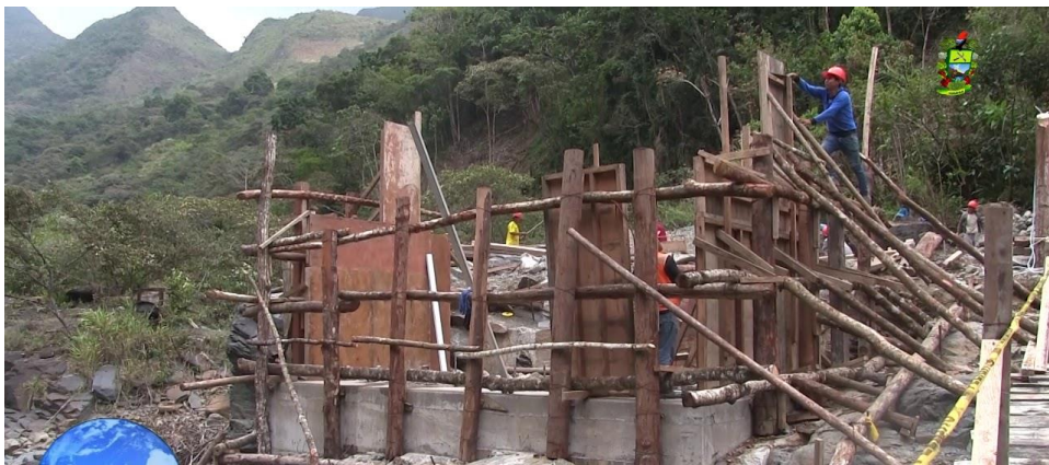
Figura 14. Encofrado del estribo del puente San Gregorio de Otalo
