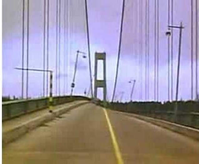
Figura 11. Puente Tacoma con 1600 m de luz
