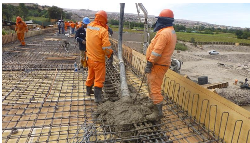
Figura 15. Vaceado del tablero con concreto en un puente losa
