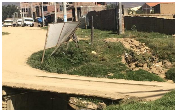
Figura 26. Lugar del puente proyectado en Chilca – Huancayo Fuente: Elaboración propia
