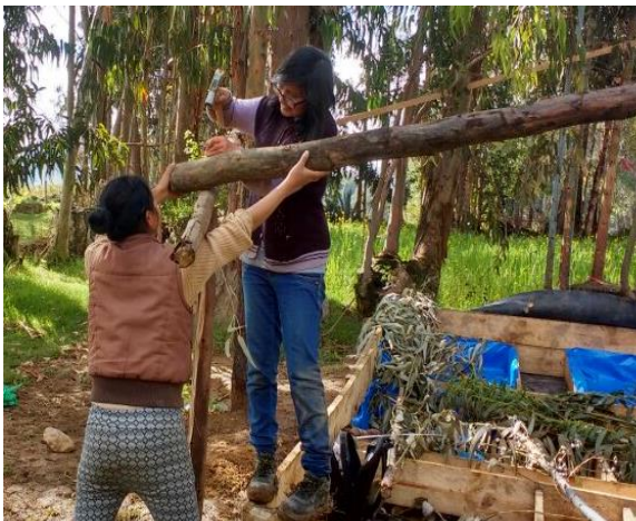
Fotografía N°03: Armado del techo
