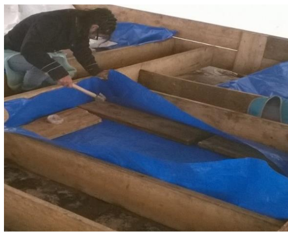
Fotografía N°04: Forrado de las pilas con el plástico plastificado
