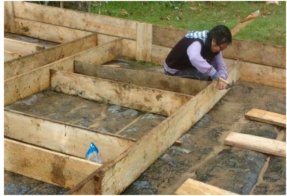
Fotografía N°02: Construcción de las pilas de compostaje
