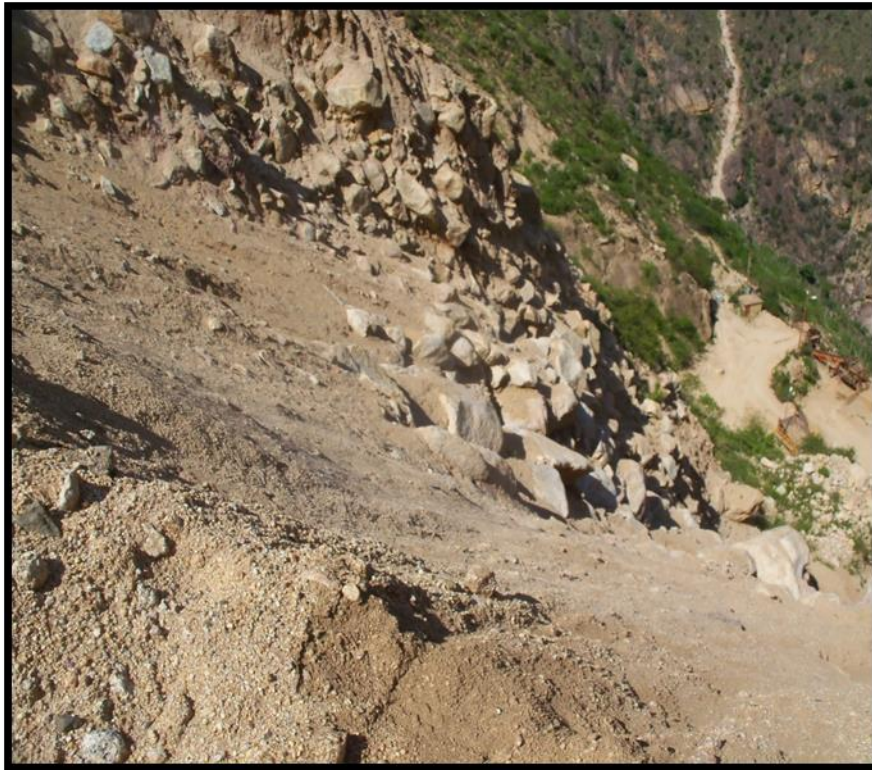
FOTOGRAFÍA N° 05 Acarreo de agregado por gravedad.
