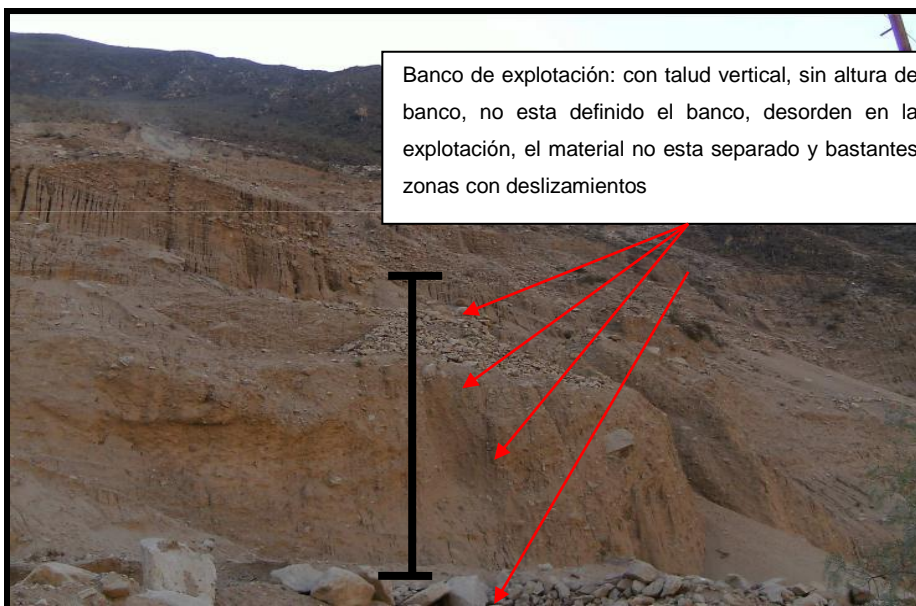
Figura N° 3 Vista Panorámica de los Bancos de Explotación
