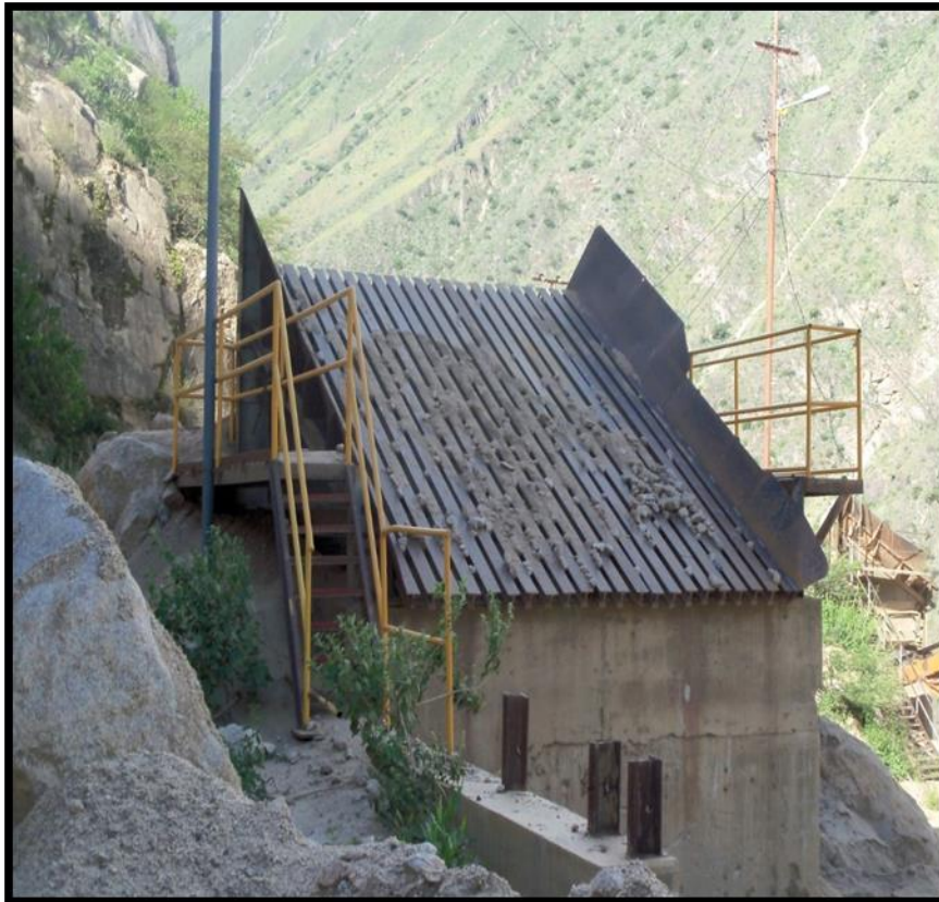
FOTOGRAFÍA N° 07 Zaranda para agregado grueso
