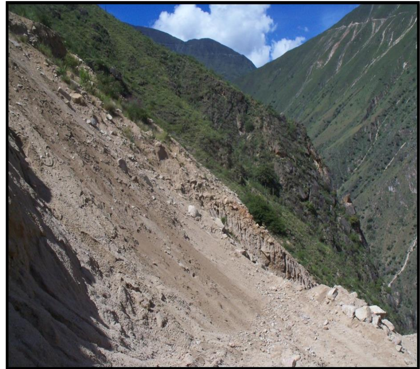
FOTOGRAFÍA N° 02 Vista del afloramiento rocoso
