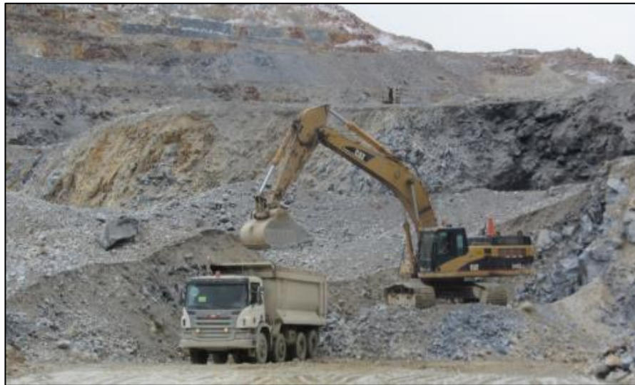
Figura 7. Excavadora CAT 345CL
