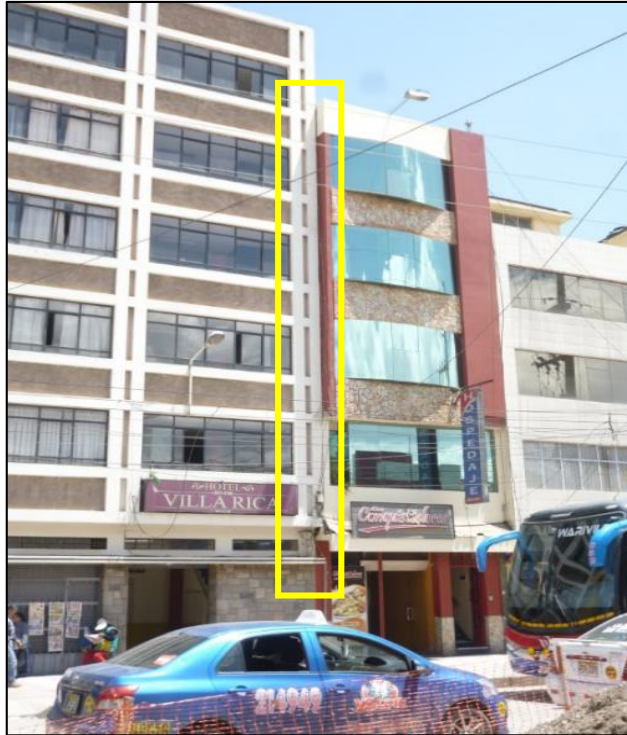
Figura 2. Falta de junta de dilatación (Av. Real – Huancayo)
