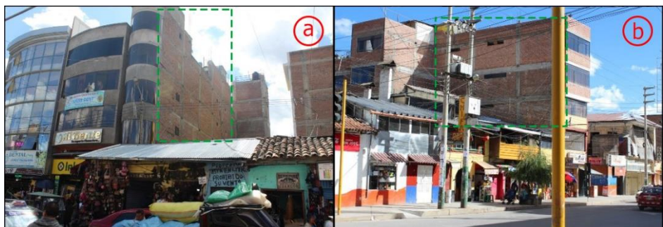
Figura 10. Edificación Ubicada en el Distrito de Huancayo. Figura 10.a. Edificación de Cinco Niveles (Centro Comercial). Figura 10.b. Edificación de Cinco Niveles (Vivienda Multifamiliar).
