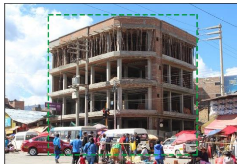
Figura 12. Edificación Ubicada en el Distrito de Huancayo.
