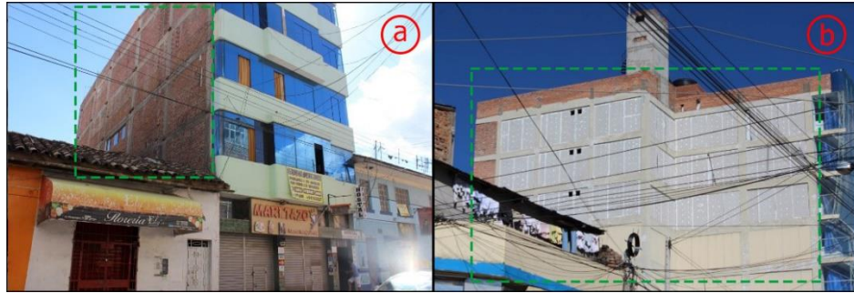
Figura 11. Edificación Ubicada en el Distrito de Huancayo.
