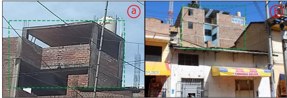
Figura 9. Edificación Ubicada en el Distrito de Huancayo. Figura 9.a. Edificación de Cinco Niveles (Vivienda Multifamiliar). Figura 9.b. Edificación de Cinco Niveles (Hospedaje).
