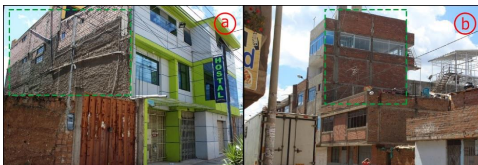
Figura 6. Edificaciones Ubicadas en el Distrito de El Tambo.
