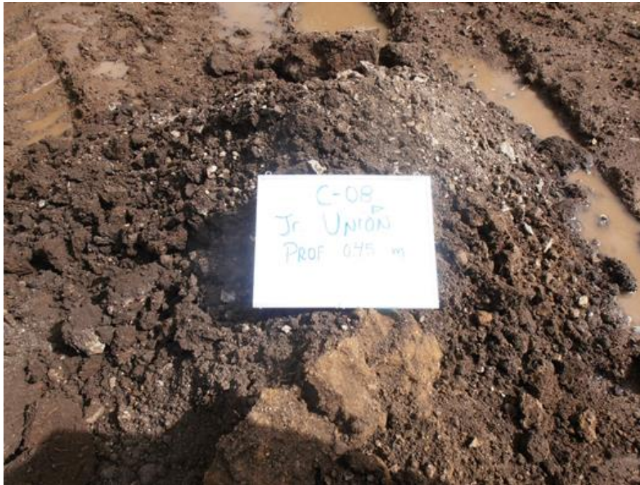
Fotografía 01: Toma de muestra calicata Prog: 3+075
