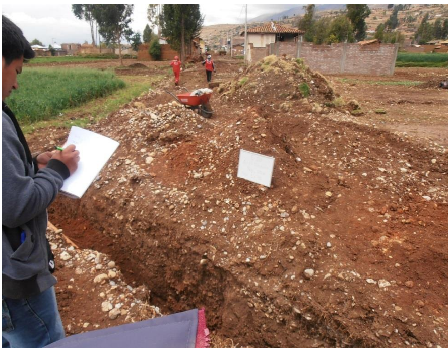
Fotografía 02: Toma de muestra Calicata Prog: 3+450
