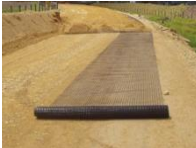
Figura 4. Geomallas biaxiales
