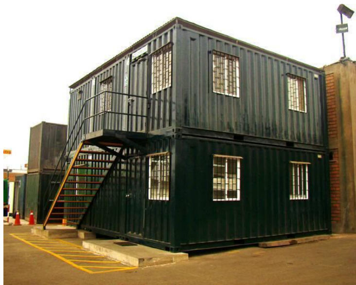
Figura 6 – Edificio 2 a base de Módulos de la empresa RANSA por la empresa Construcciones Modulares S.A. - 2017 Fuente: Empresa
