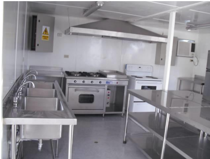
Figura 10 - Ambiente: cocina - Empresa Construcciones Modulares S.A. - 2017 Fuente: Empresa
