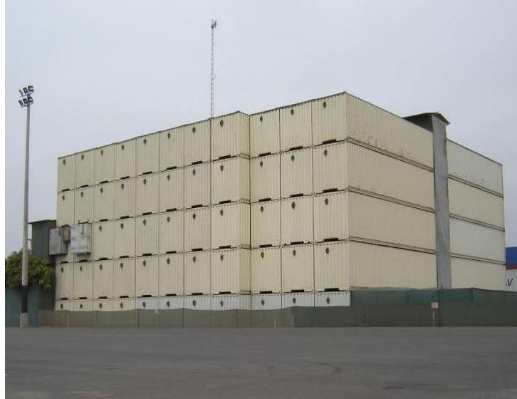
Figura 5 - Edificio a base de Módulos de la empresa RANSA por la empresa Construcciones Modulares S.A. - 2017 Fuente: Empresa
