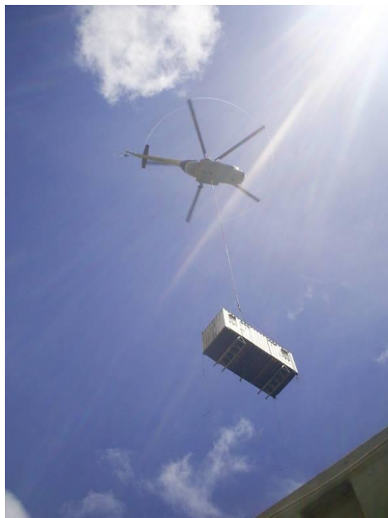
Figura 4 - Transporte de Módulos vía aérea por la empresa Construcciones Modulares S.A. - 2017 Fuente: Empresa
