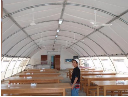
Figura 13 - Carpa: comedor - Empresa Construcciones Modulares S.A. - 2017 Fuente: Empresa
