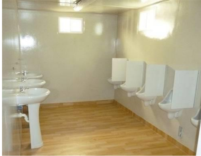
Figura 9 - Ambiente: baño - Empresa Construcciones Modulares S.A. - 2017 Fuente: Empresa
