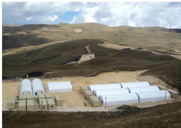
Figura 15 - Campamento a base de carpas fabricado por la empresa Construcciones Modulares S.A. - 2017 Fuente: Empresa
