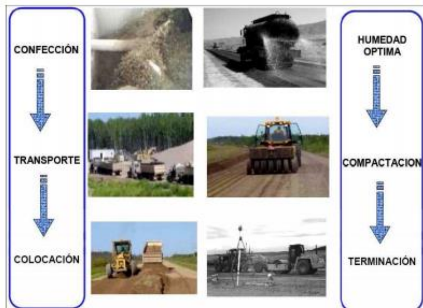
Figura 3: Etapas para la preparación de la base
