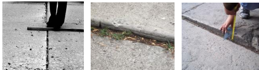
Figura 11: Fisura escalonamiento – baja, media y alta.
