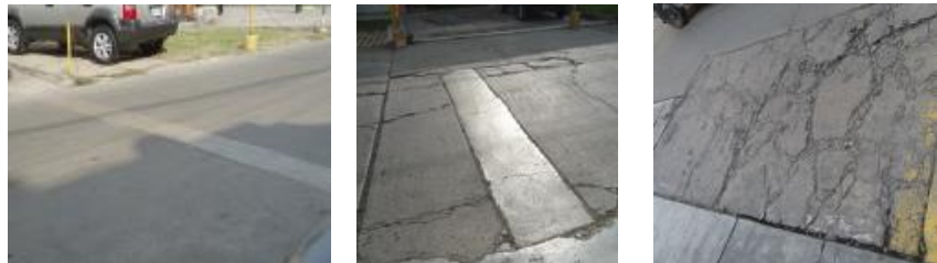
Figura 16: Parches y acometidas de servicios públicos – severidad baja, media y alta respectivamente.
