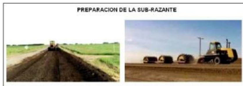
Figura 2: Etapas para la preparación de la Subrasante
