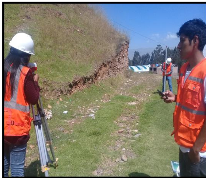
Foto 04: Armado y medición con el nivel de ingeniero en el grupo experimental.
