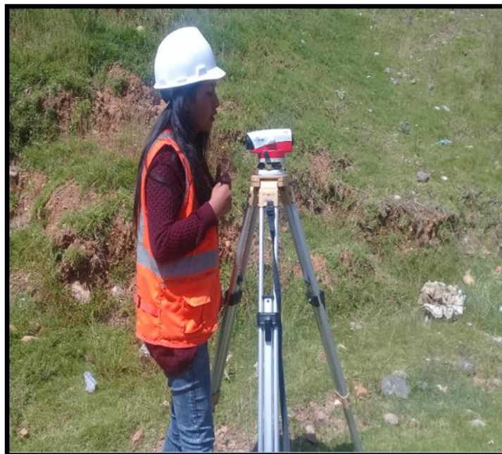
Foto 02: Armado y medición con el nivel de ingeniero en el grupo control
