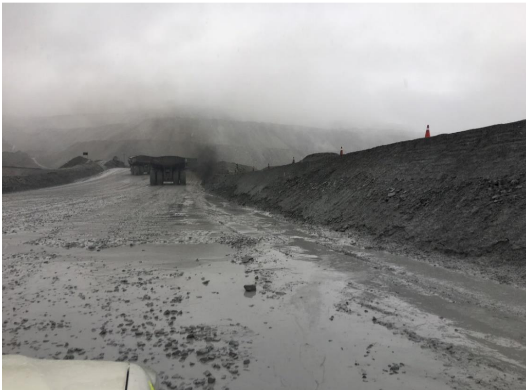
Figura 4: Pendiente en campo menor al 2%, se laven los finos, generando baches y huecos
