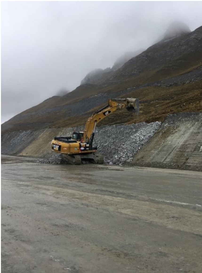
Figura 21: Ejecución de ventanas para drenaje
