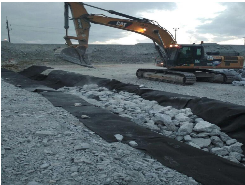
Figura 17: Conformación de Dren Francés para garantizar el drenaje subterráneo generado por las precipitaciones altas
