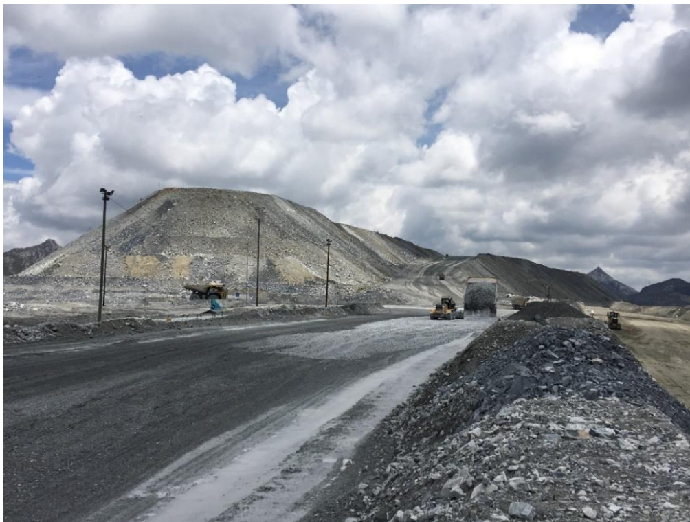
Figura 1: Lastrado de vías luego de la descarga del material
