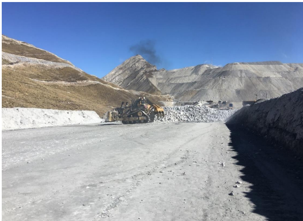
Figura 16: Corte del terreno con tractor D11T, para conseguir subrasante con pendiente 5%
