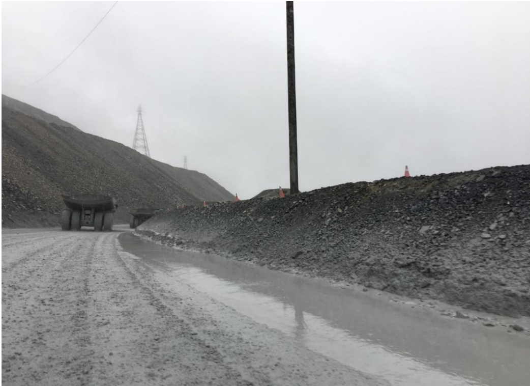
Figura 5: Concentración de lodo generado por precipitaciones
