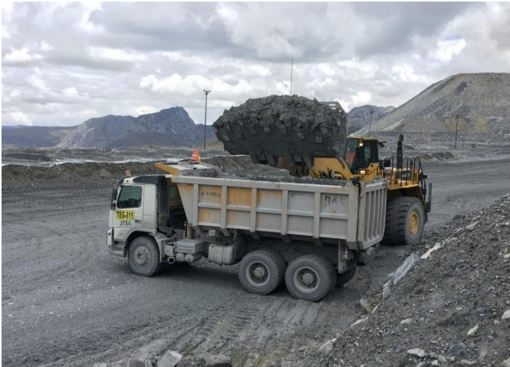
Figura 6: Eliminación de lodo con volquetes, por falta de drenaje en el punto
