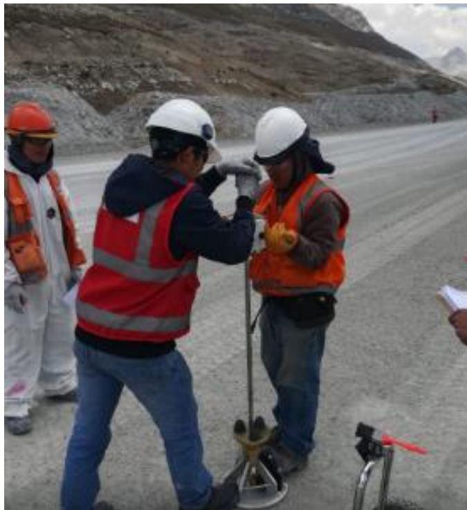
Figura 109. Evaluación estructural con Deflectómetro Liviano.
