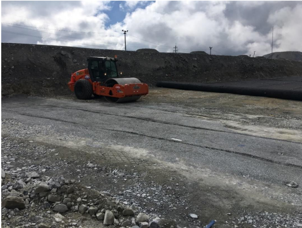
Figura 18: Sellado y compactado de dren francés con material rechazado
