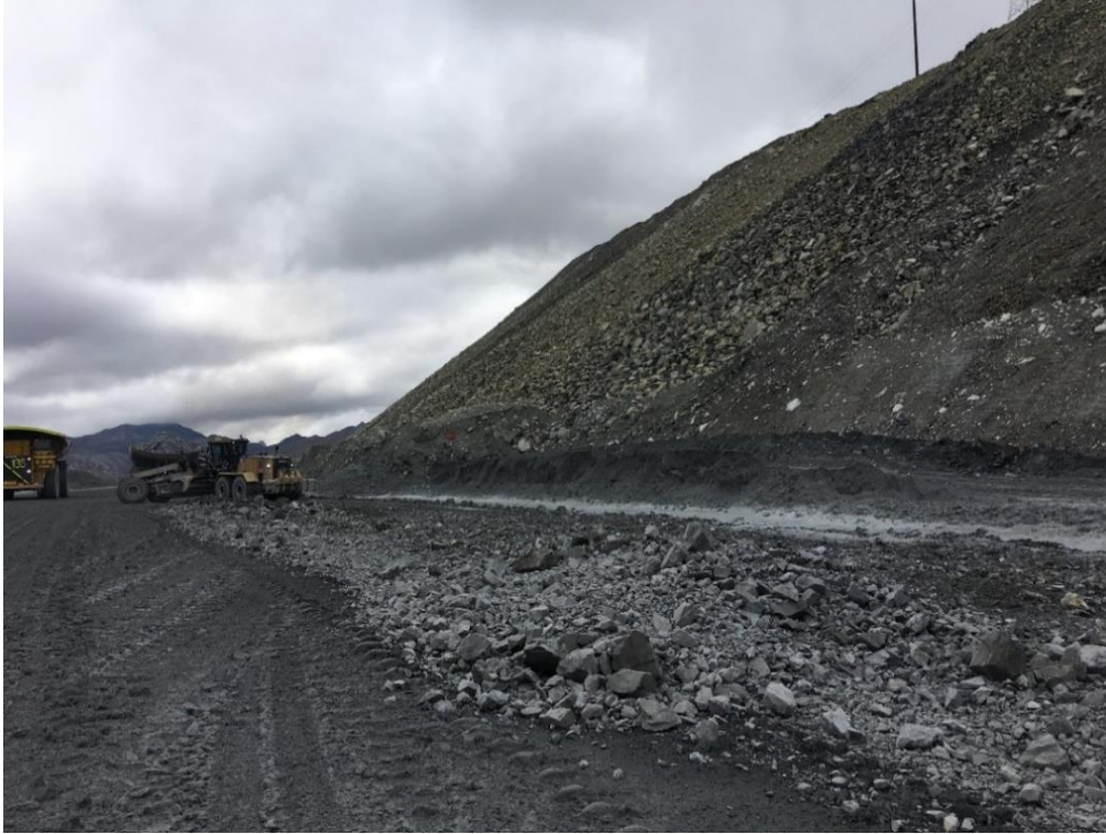
Figura 2: Lastrado con rocas de mayor dimensión
