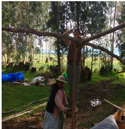
Fotografía N°4: Armado del techo.
