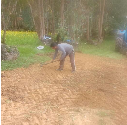
Fotografía N°1: Nivelación del terreno.
