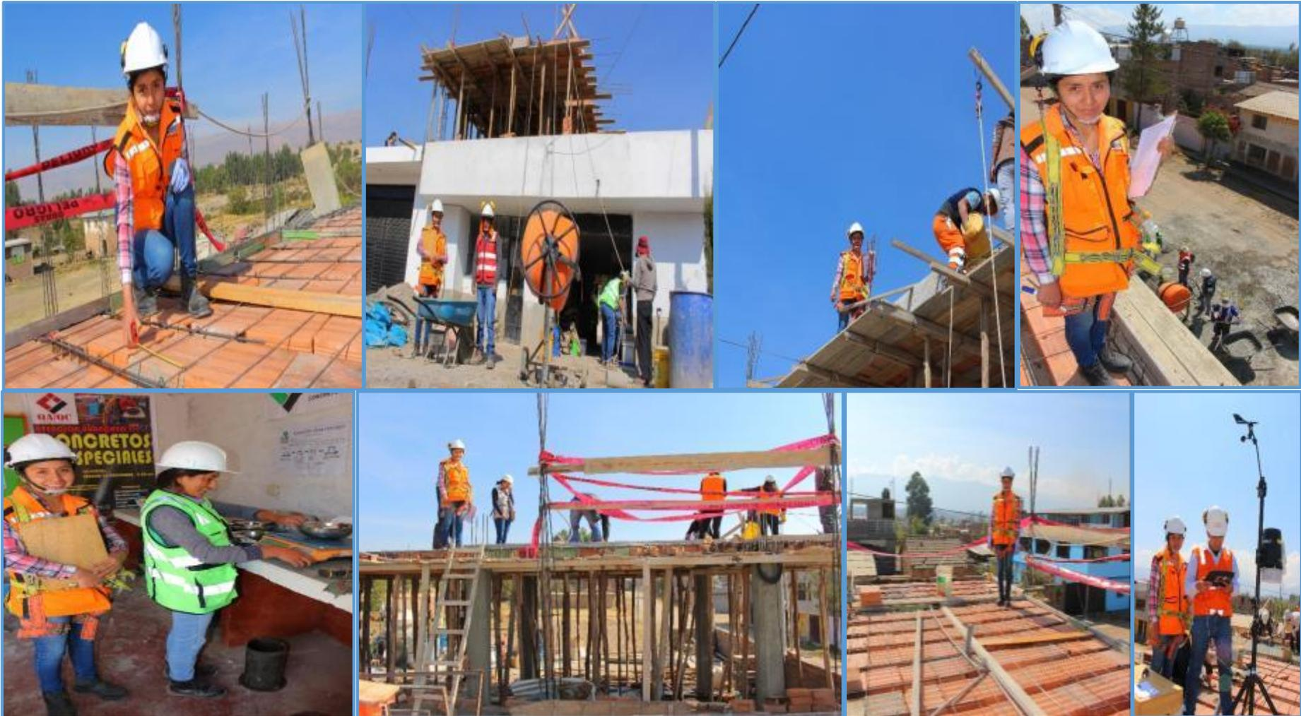
**Collage Fotográfico 01:** La investigadora procede con la revisión de dimensiones de las separaciones del acero de temperatura, delimitación de las áreas e inspección del área de trabajo, control de materiales, herramienta y equipos, verificación de la seguridad en obra, para así proceder con el vaciado del concreto y control de la fisuración por contracción plástica en losas aligeradas. 2017. Fuente Propia.
