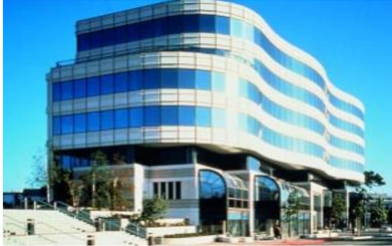
**Figura 7.** Uso de fibra de vidrio en los paneles de la fachada.
