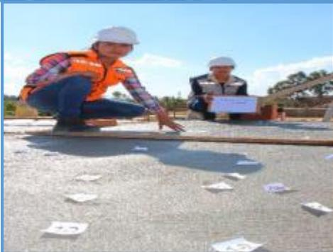
**Collage Fotográfico 08:** Control de fisuración por contracción plástica en losa aligerada para una combinación de mezcla  $f'c = 280 \text{ kg/cm}^2$  L3-D1. 2017. Fuente Propia.
