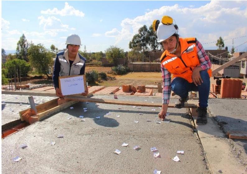
**Figura 18.** Control de fisuras en losa aligerada con  $f'c = 245 \text{ kg/cm}^2$  con el uso de fibras sintéticas de rafia
