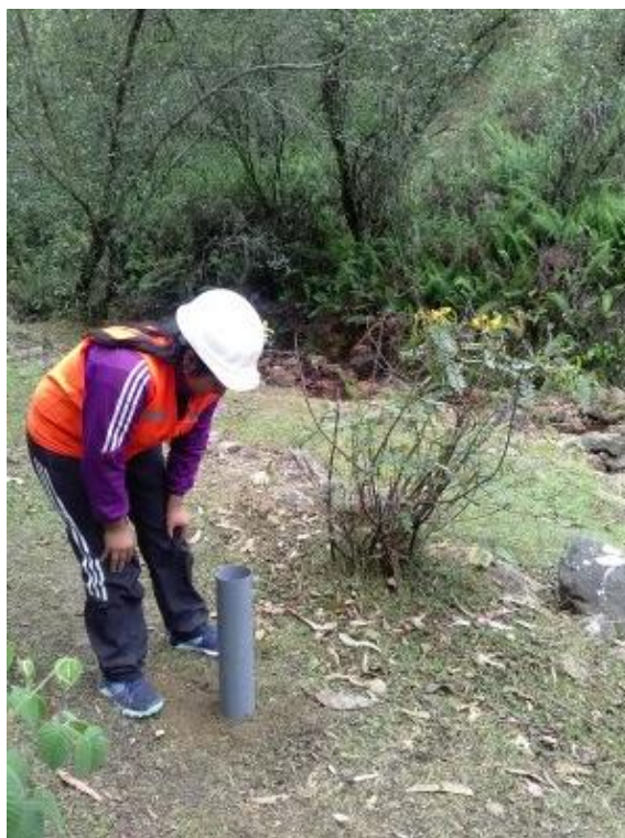
FOTOGRAFIA N°02: Prueba de infiltración – ACP Ilish Pichacoto.
