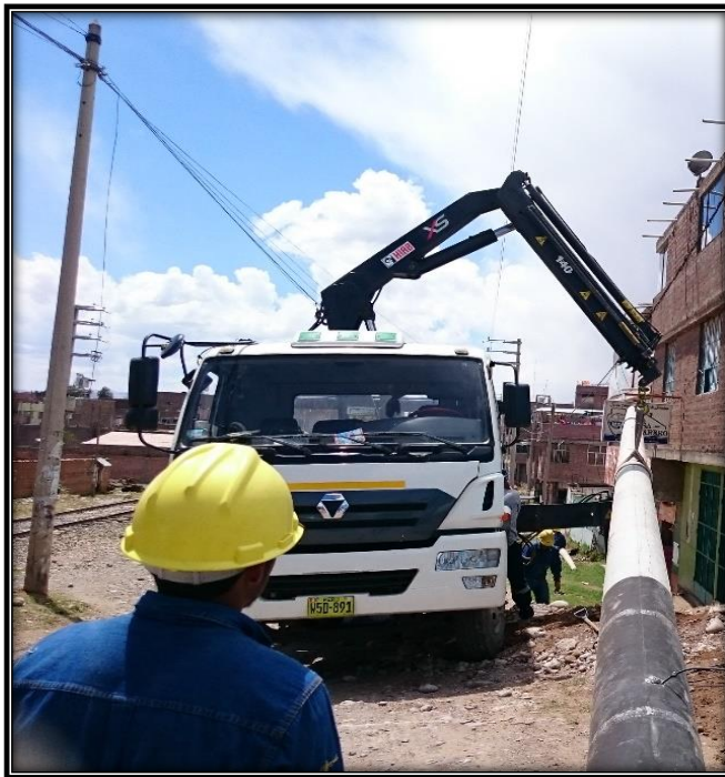
Figura: 19 Izado de poste de 15/500.
