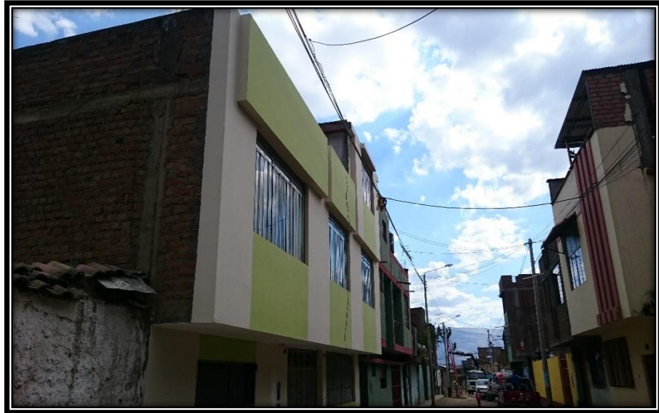
Figura 9: Incumplimiento de distancias mínimas de seguridad
