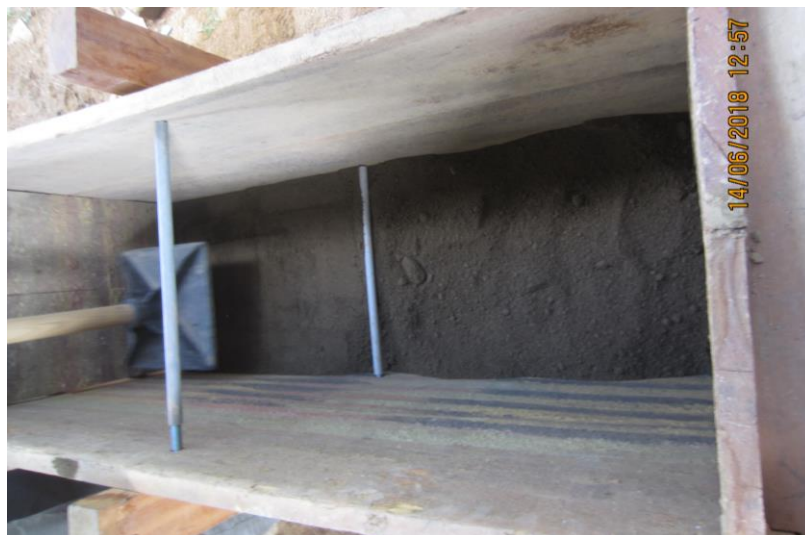
Figura 98 Primera capa de mezcla Fuente: Elaboración Propia
