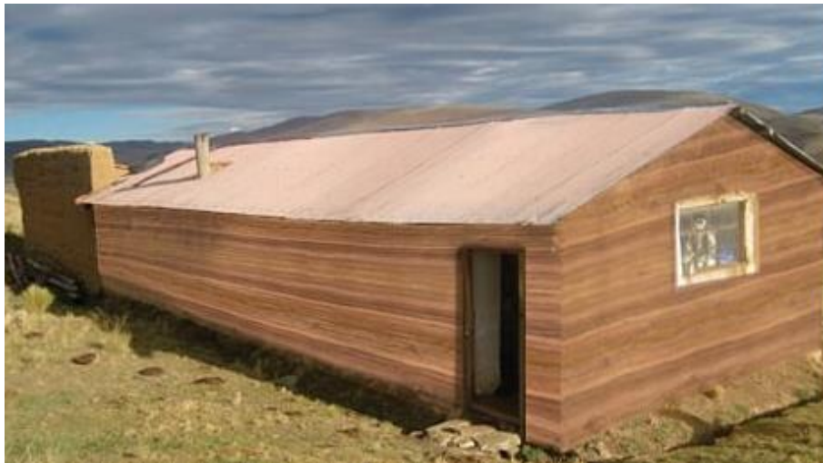
Figura 116 Vivienda N° 24 tratamiento con óxidos ferrosos
