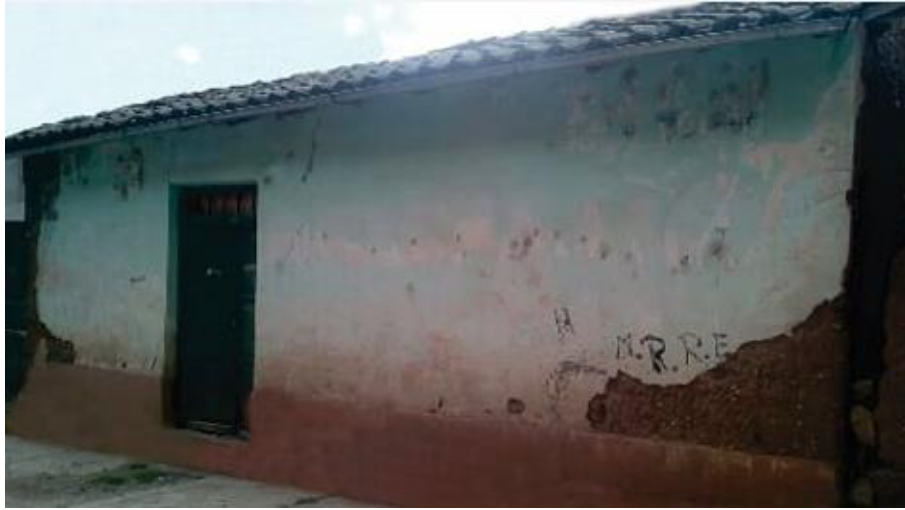
Figura 109 Vivienda N° 13 estado actual
