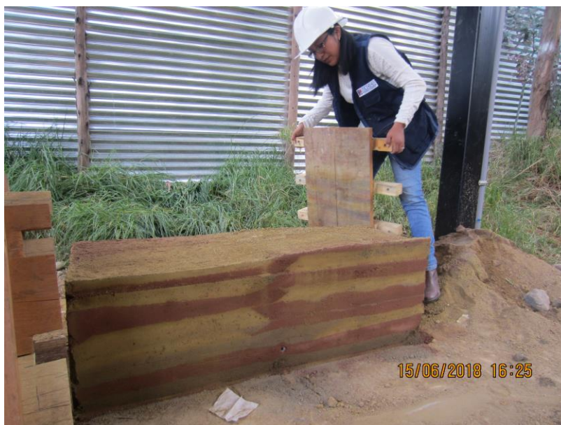
Figura 102 Última parte del desencofrado
