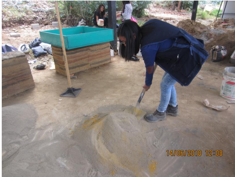
Figura 94 Mezcla de tierra, cemento y ocre amarillo
