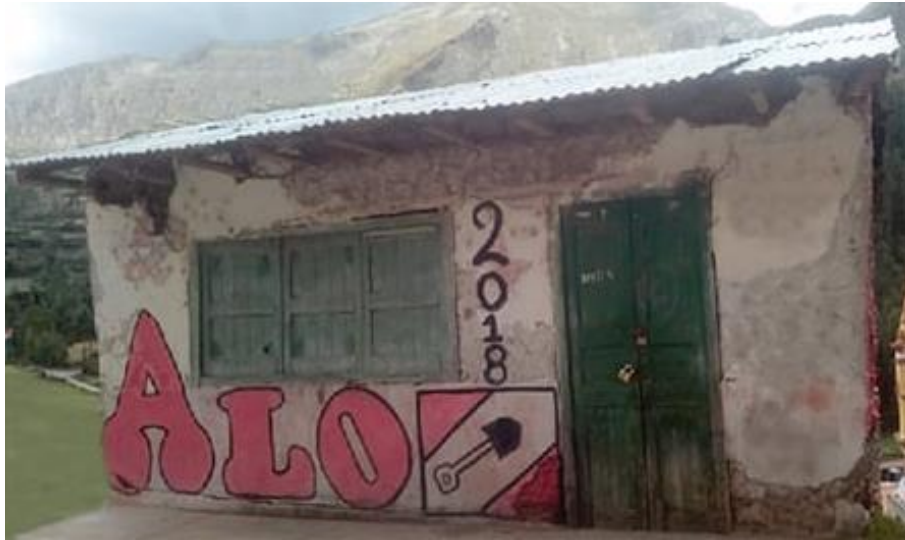
Figura 111 Vivienda N° 14 estado actual
