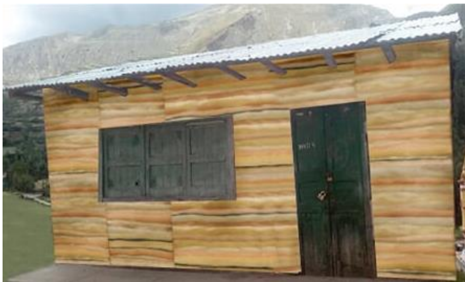
Figura 112 Vivienda N° 14 tratamiento con óxidos ferrosos
