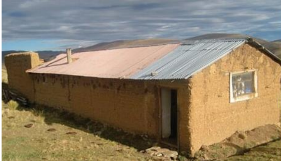
Figura 115 Vivienda N° 24 estado actual
