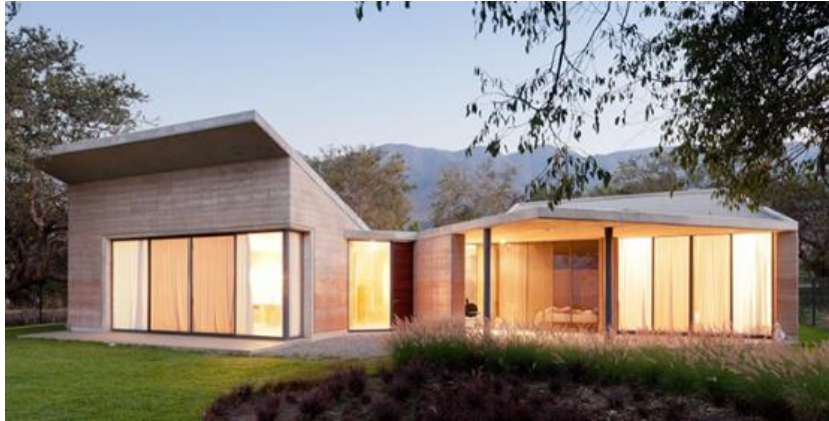
Figura 117 Edificación Representativa N° 01 Casa Ajijic Fuente: Archdaily (21)
