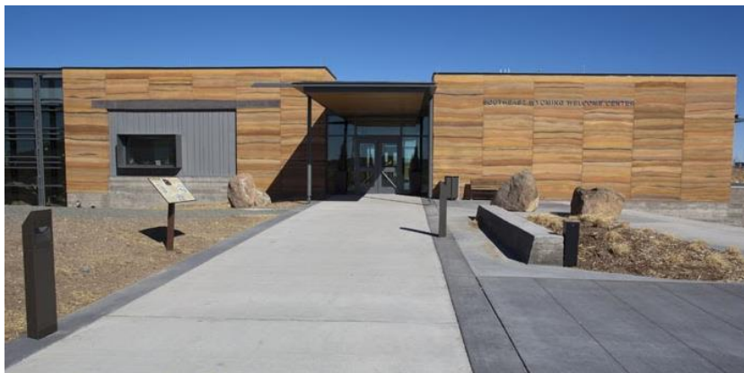
Figura 121 Edificación Representativa N° 02 Southeast Wyoming Welcome Center Fuente: Archdaily (21)
