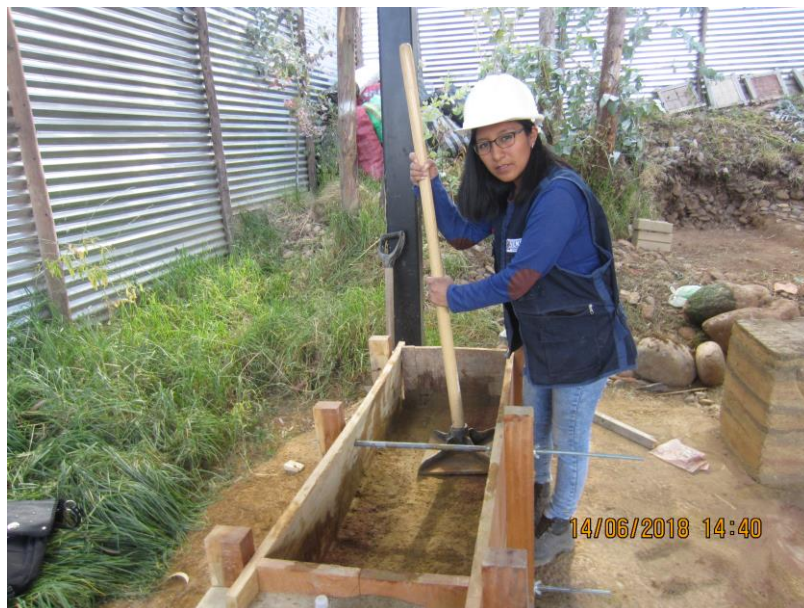
Figura 100 Apisonado de tierra en capas de 10 cm
