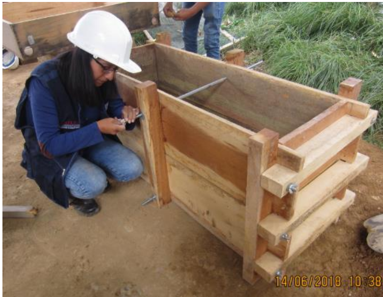
Figura 91 Armado de molde
