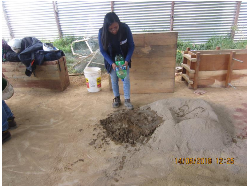
Figura 96 Mezcla de tierra, cemento y ocre amarillo
