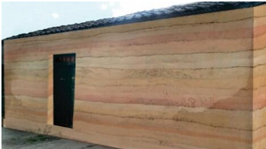
Figura 110 Vivienda N° 13 tratamiento con óxidos ferrosos
