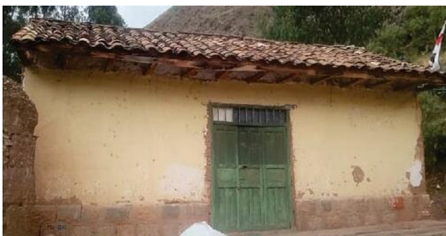
Figura 107 Vivienda N° 11 estado actual
