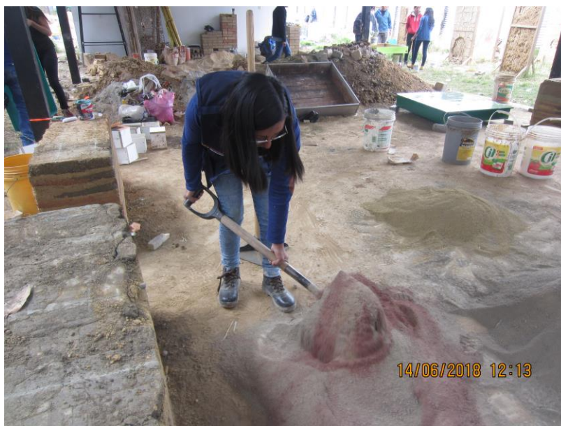
Figura 95 Mezcla de tierra, cemento y ocre rojo
