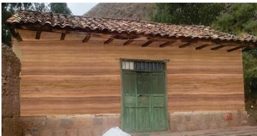
Figura 108 Vivienda N° 11 tratamiento con óxidos ferrosos
