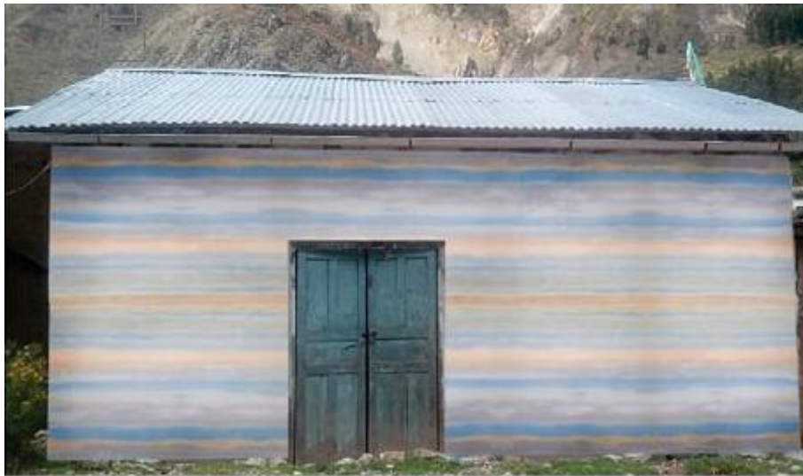
Figura 114 Vivienda N° 16 tratamiento con óxidos ferrosos
