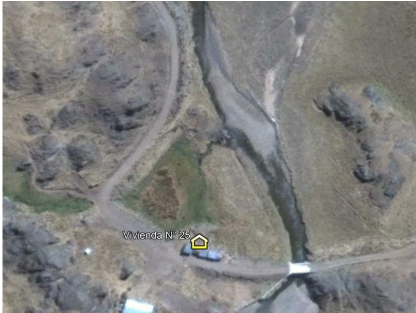
Figura 54 Ubicación de vivienda N° 25 Fuente: Elaboración Propia
