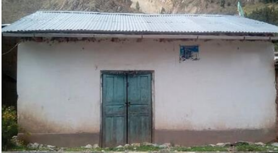
Figura 113 Vivienda N° 16 estado actual
