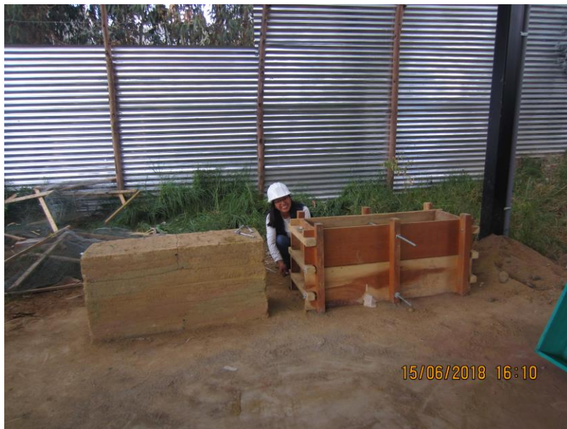
Figura 101 Desencofrado de muestra
