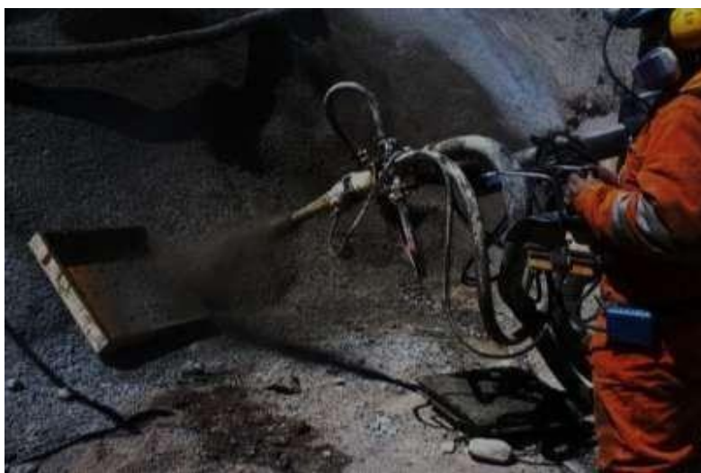
Figura 19: Proceso de lanzado de concreto en el molde de Panel para Ensayos Fuente: fotografía tomada por el autor
