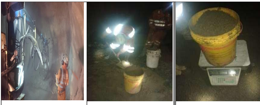
Figuras 43, 44 y 45. Preparación y ejecución de la prueba de rebote
