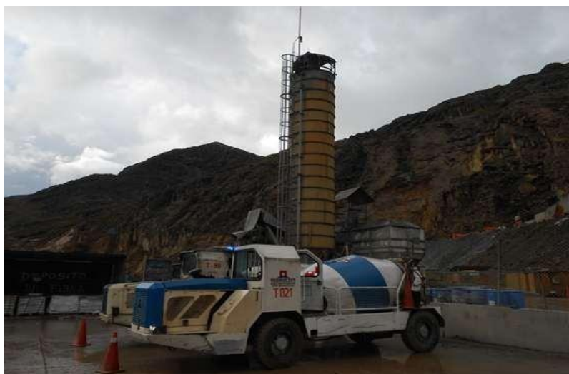
Figura 25. Planta de Concreto - San Cristóbal
