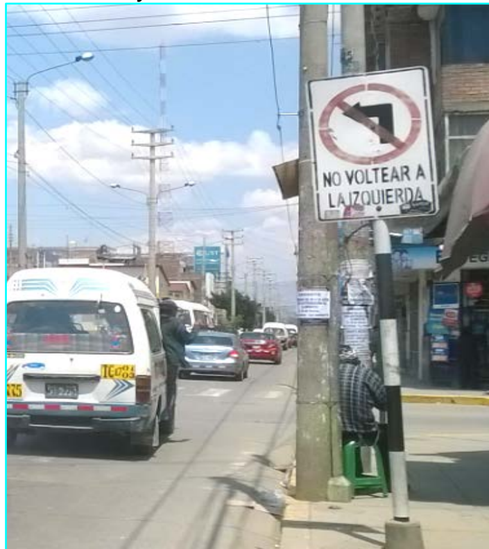
Fotografía 15. Señalización vertical reglamentaria – no voltear a la izquierda Av. Huancavelica en su sentido NS y Jr. Cuzco
