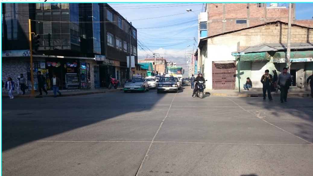
Fotografía 14. Ausencia de señalización horizontales - Av. Huancavelica y Jr. Cuzco en su sentido NS y SN
