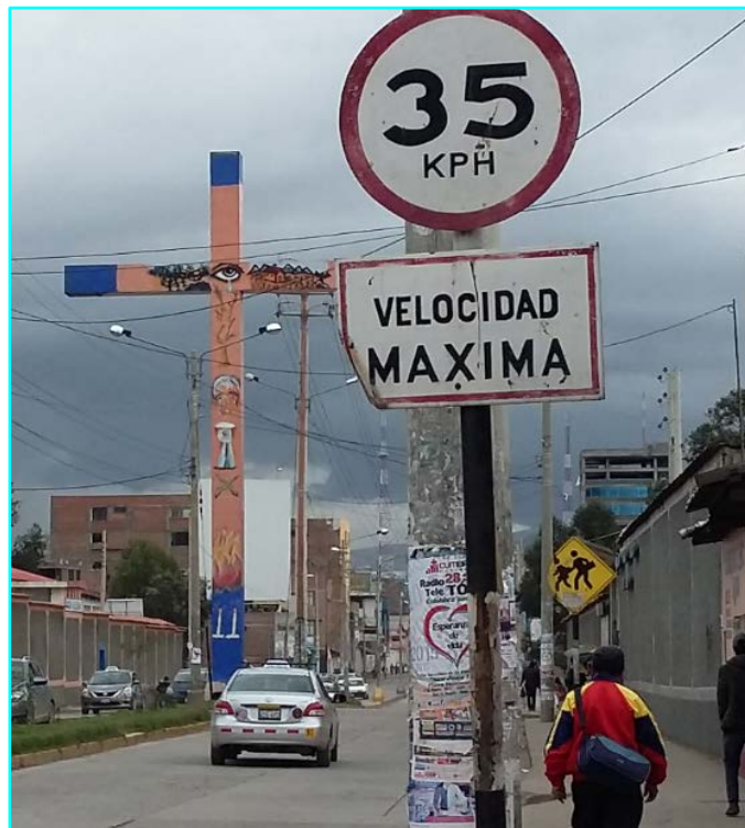
Fotografía 16. Señalización vertical reglamentaria – velocidad máxima - Av. Huancavelica en su sentido NS
