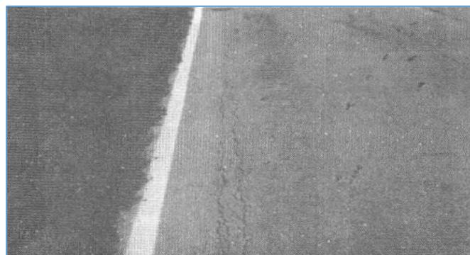
**FIGURA 27.** Agrietamiento por reflexión en juntas de losas de concreto.
