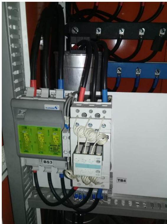
Fotografía N° 06: Sistema de mando y protección de un paso Fuente: Compañía Minera Volcán S.A.A.
