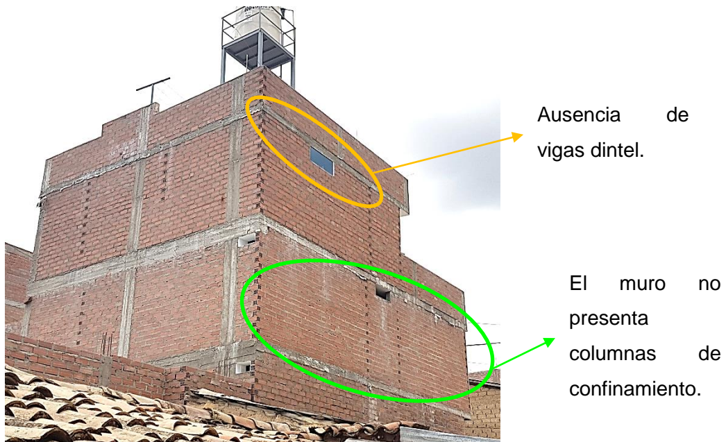
Figura 1: Edificación ubicada en Psje. Libertad Fuente: Propia
