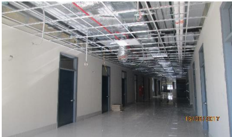
Imagen 147 : Contrazócalos sanitario porcelanatos – Pasadizo unidad de consulta Externa.
