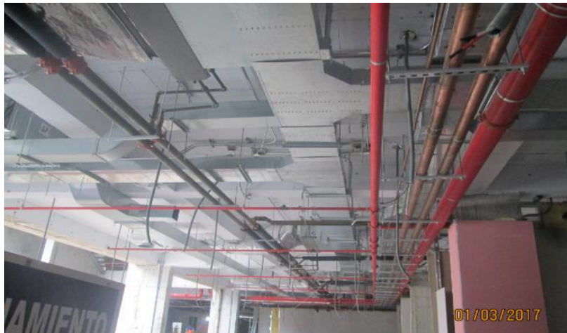
Imagen 186 : Pruebas hidráulica de la red de contraincendios.
