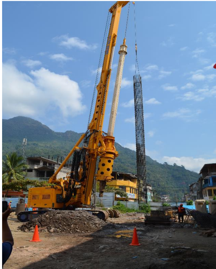
Imagen 58 : Instalación del pilote dentro de la entubación
