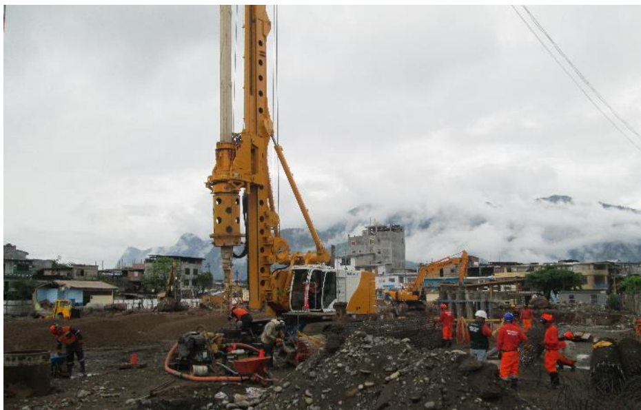
Imagen 50 : Perforación de pilote sector 01 y 02.
