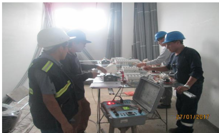
Imagen 201 : Pruebas de Megado de los tableros de distribución.
