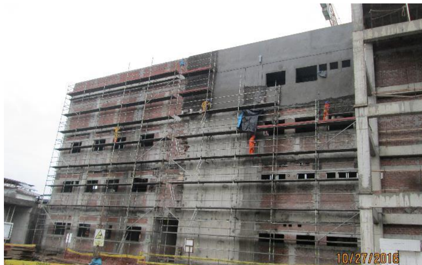
Imagen 117 : Tarrajeo fachada muros sector 01
