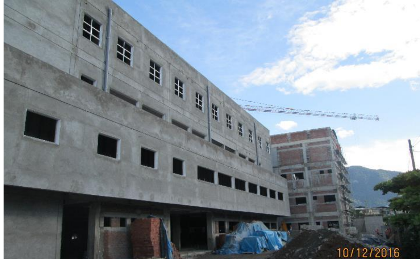
Imagen 117 : Tarrajeo fachada muros sector 01
