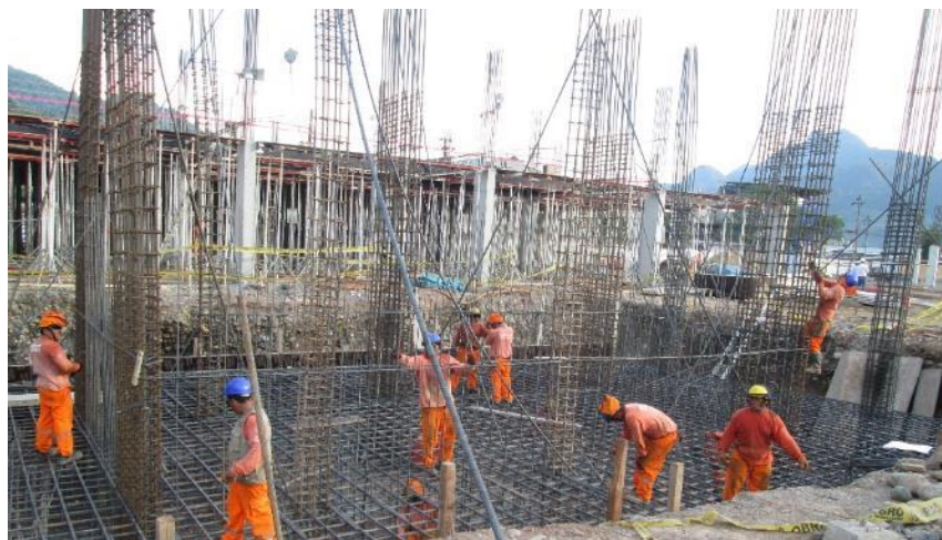
Imagen 72 : Colocación de armaduras de acero en placas – Sector 1, piso 2.
