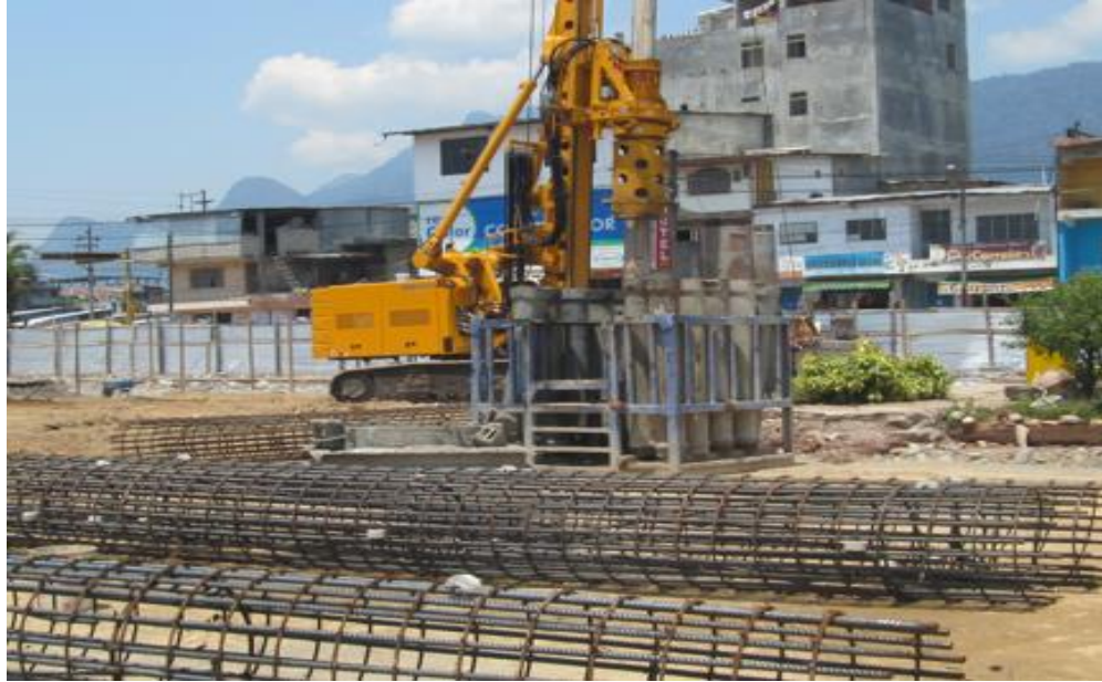
Imagen 58 : Instalación del pilote dentro de la entubación
