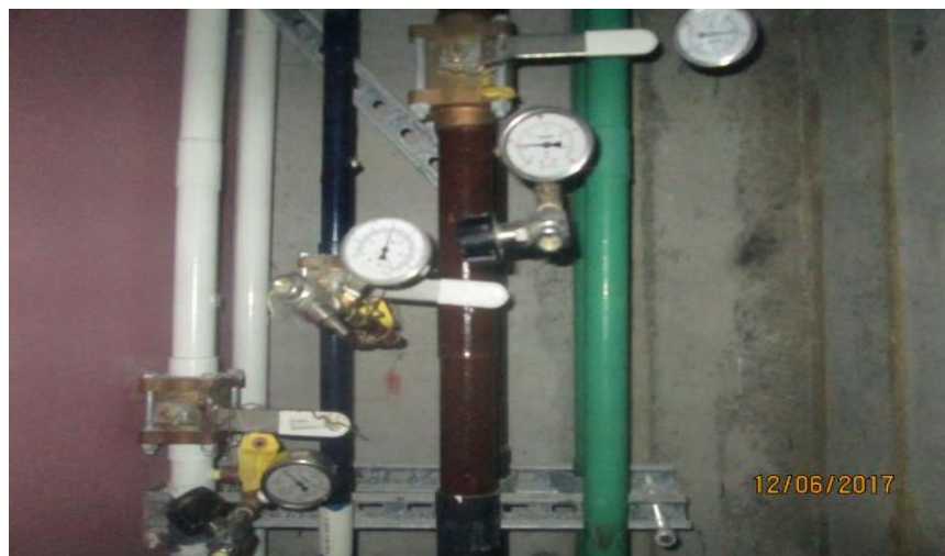
Imagen 174 : Control de calidad de redes principales de gases medicinales Sector 04.
