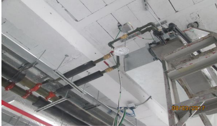
Imagen 171 : Pruebas de calidad drenaje fan coil.
