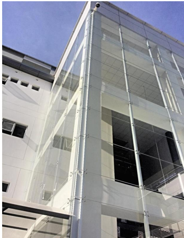
Imagen 165 : Pasadizo área hospitalización – sector 03, nivel 03.
