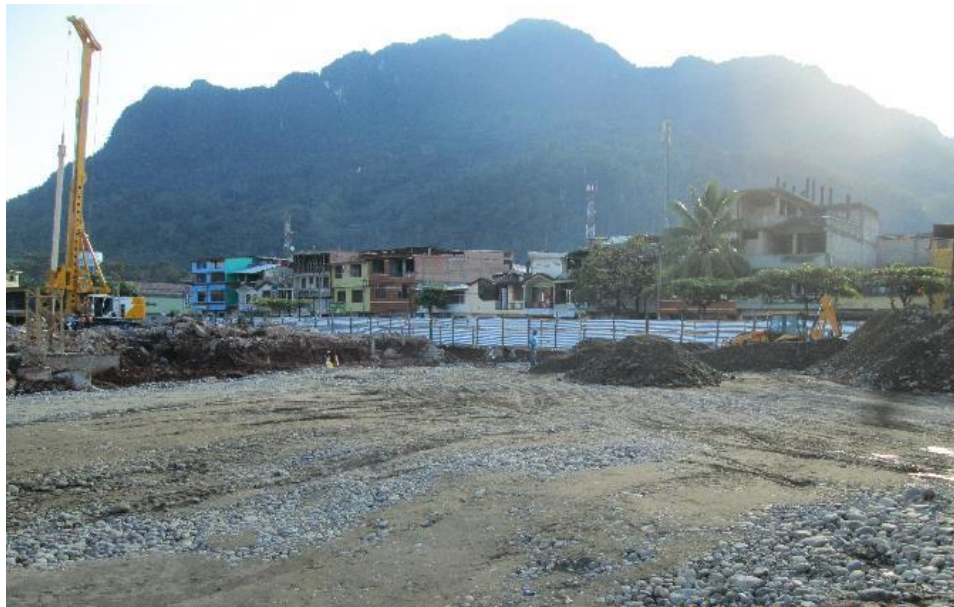
Imagen 44 : Mejoramiento de suelo
