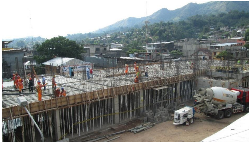
Imagen 89 : Vaciado – Losa Sector 1.piso 1.
