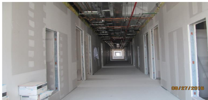
Imagen 136 : Tabiquería seca instalados en pasadizos área confort médico. Sector 2, nivel 02
