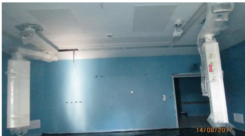
Imagen 143 : Falso Cielo raso con Drywal en Quirófano.
