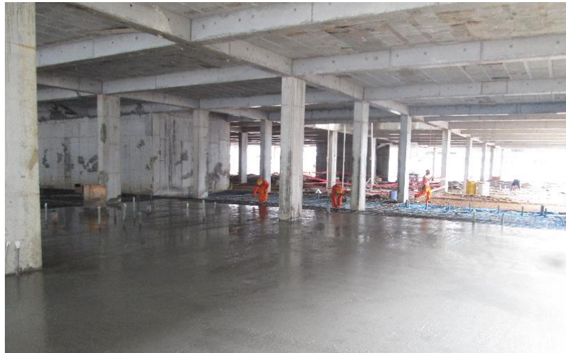
Imagen 120 : Pisos armados – nivel 01 sector 04.
