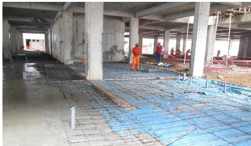
Imagen 120 : Pisos armados – nivel 01 sector 04.
