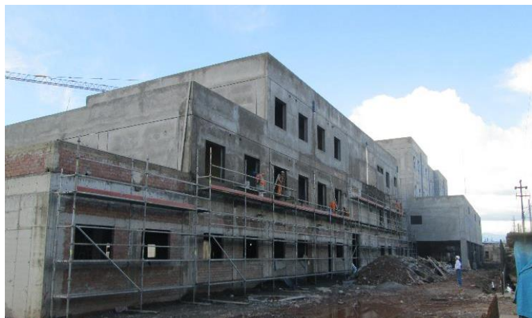
Imagen 115 : Tarrajeo fachada sector 03.
