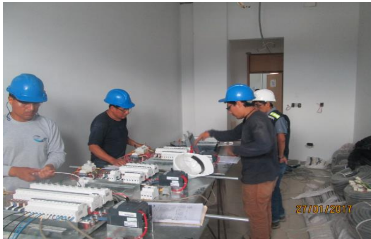
Imagen 203 : Trabajos de cableado - Alimentadores
