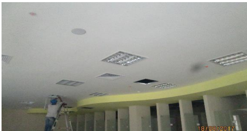
Imagen 142 : Falso Cielo raso con Drywal – área farmacias.
