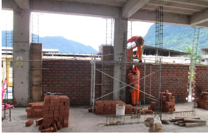
Imagen 106: Muro de ladrillo KK-18H aparejo soga- Sector 03, nivel 01.
