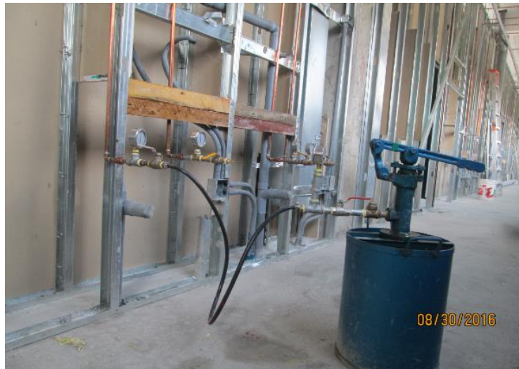
Imagen 190 : Prueba hidráulica de la red de agua fría y caliente –sector 04, nivel 02.
