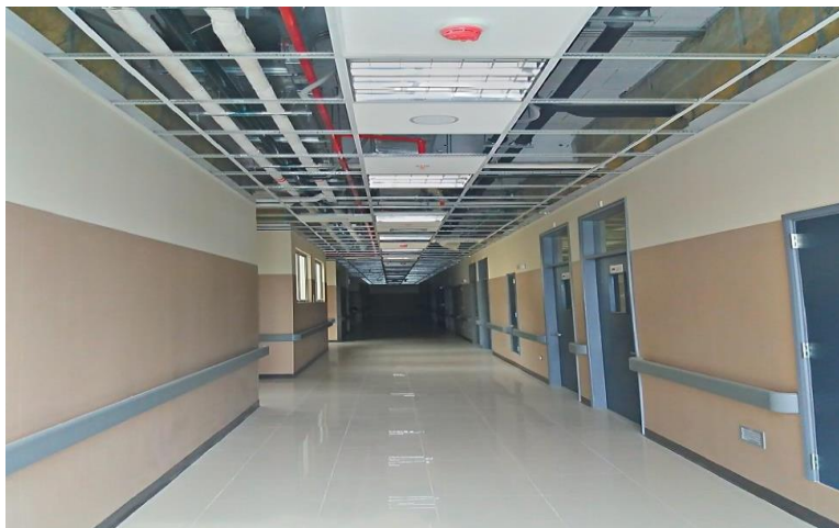
Imagen 157 : Pasadizo área hospitalización – sector 03, nivel 03.
