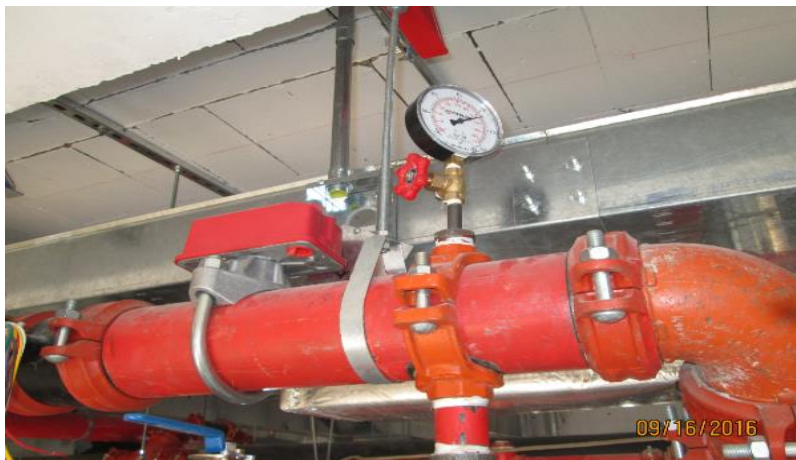
Imagen 186 : Pruebas hidráulica de la red de contraincendios.
