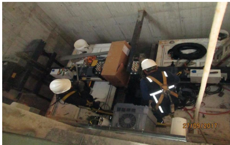
Imagen 178 : Instalación de ascensores – Montacamillas.
