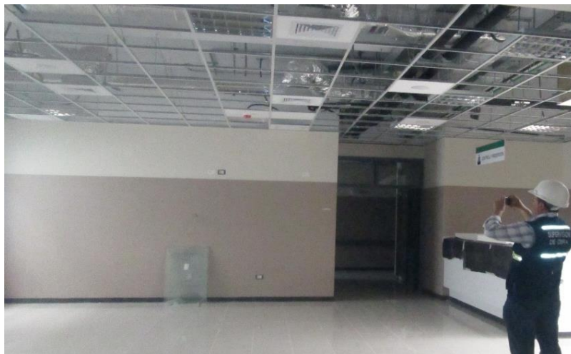
Imagen 145 : Zócalos y Contrazócalos de vinílico
