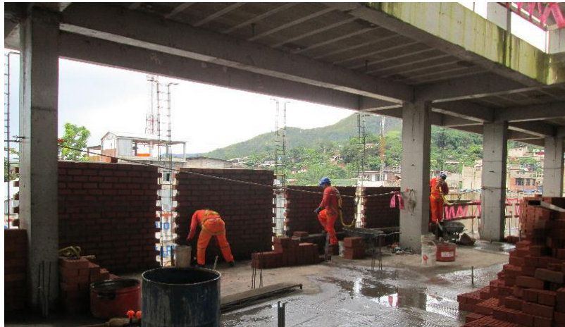
Imagen 106: Muro de ladrillo KK-18H aparejo soga- Sector 03, nivel 01.
