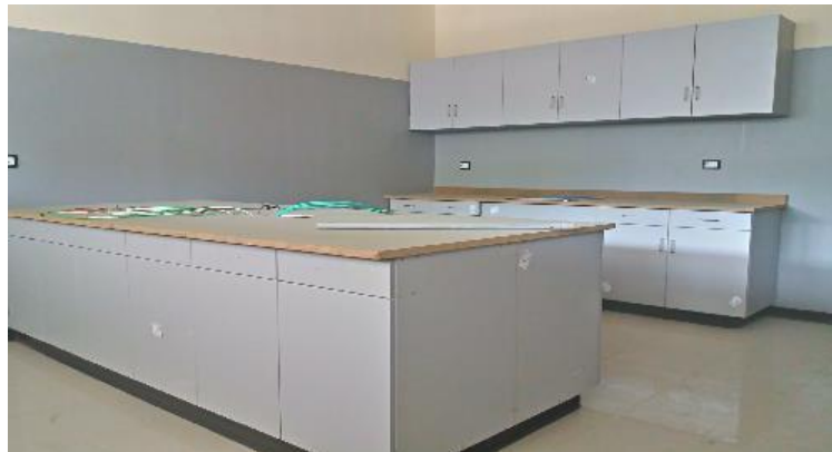
Imagen 150 : Muebles de melamina y madera – Laboratorio Bioquímica.
