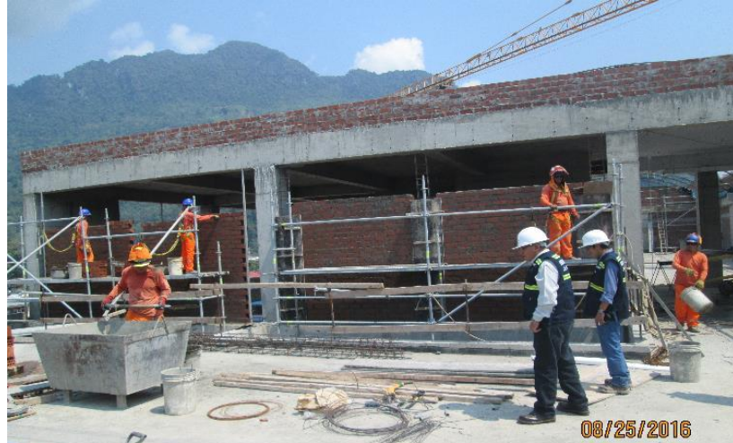
Imagen 109 : Muro de ladrillo KK-18H aparejo soga – fachada sector 04.
