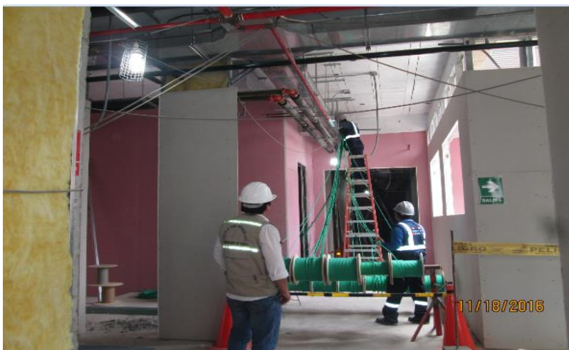
Imagen 213 : Cableado para sistema de comunicaciones – Gabinete de Comunicaciones.
