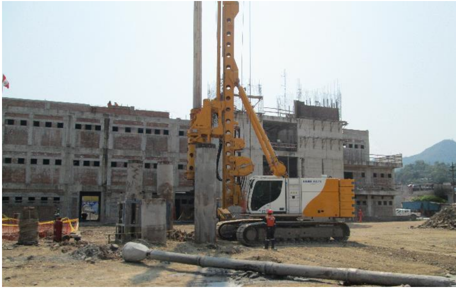
Imagen 52 : Introducción de entubación recuperable. Sector 01 y 02.
