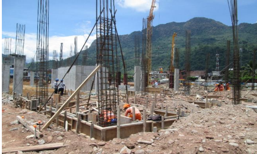
Imagen 70 : Colocación de armaduras de acero en placas – caja de escalera sector 03.
