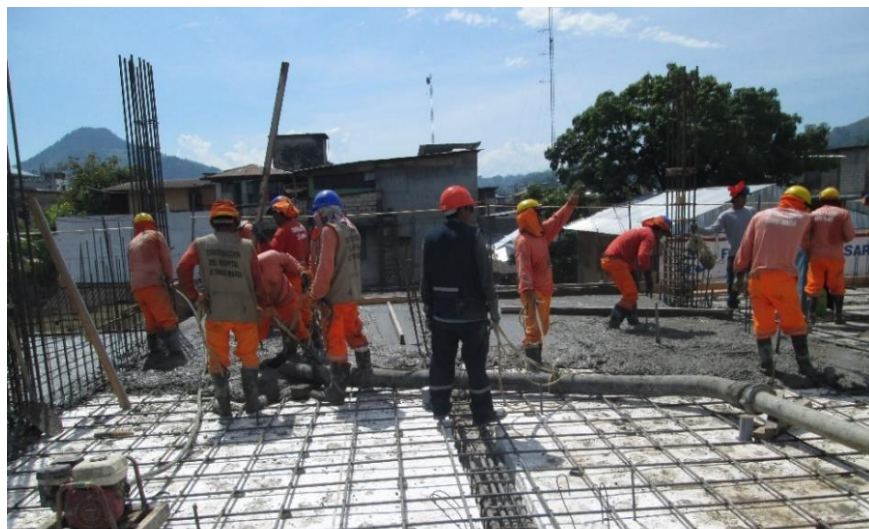
Imagen 90 : Vaciado – Losa Sector 2.piso 2
