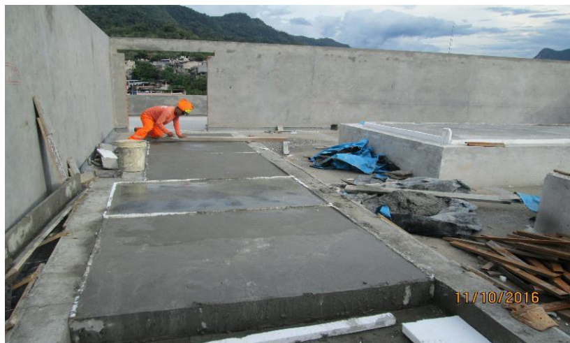
Imagen 122 : Pisos de concreto para base de CHILLERs y Bombas.
