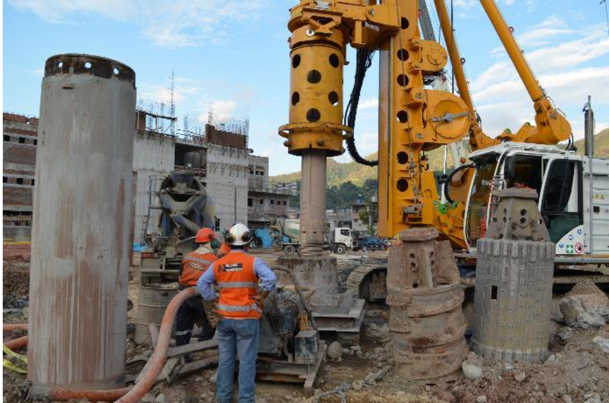
Imagen 50 : Perforación de pilote sector 01 y 02.
