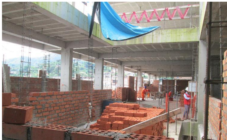
Imagen 108 : Muro de ladrillo KK-18H aparejo soga- piso 03, Sector 02.
