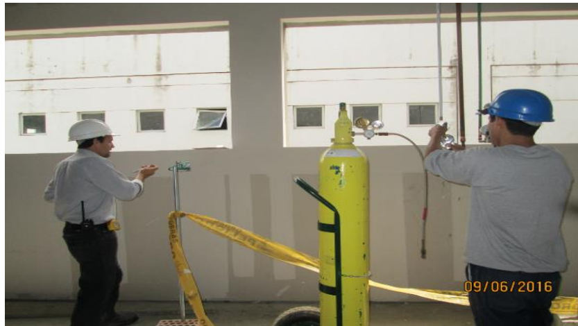
Imagen 174 : Control de calidad de redes principales de gases medicinales Sector 04.
