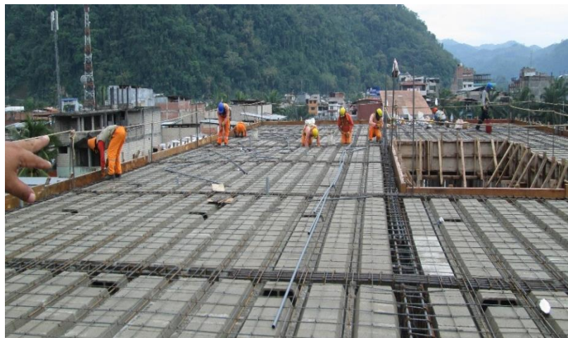
Imagen 88 : Bloquetas – Losa Sector 3.piso 3.
