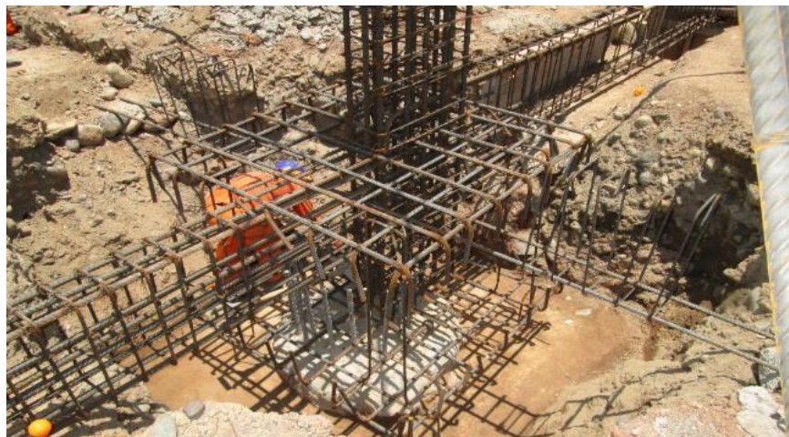
Imagen 66 : Armaduras de acero unión cimentaciones y columnas
