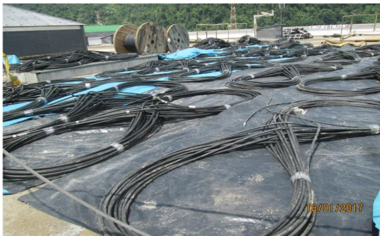
Imagen 204 : Cables de baja tensión para alimentadores
