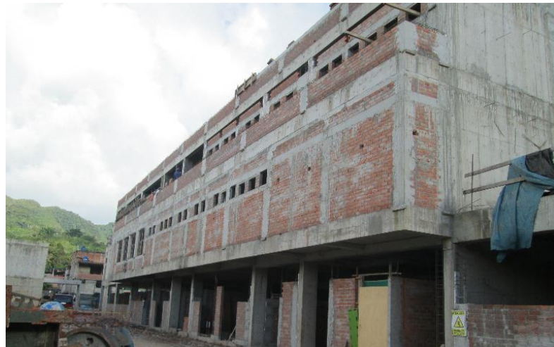
Imagen 109 : Muro de ladrillo KK-18H aparejo soga – fachada sector 04.
