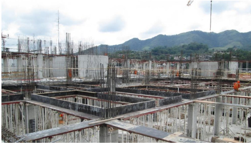
Imagen 78 : Colocación de soportes para losa
