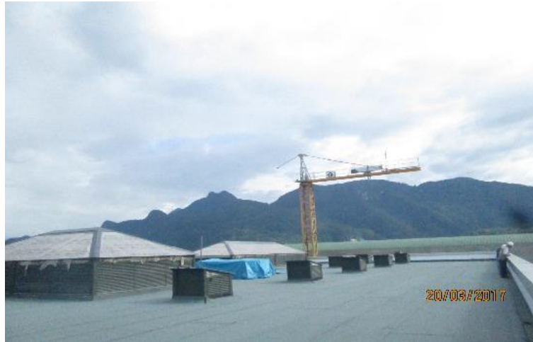
Imagen 152 : Manto impermeabilizante en techos expuestos a la intemperie.
