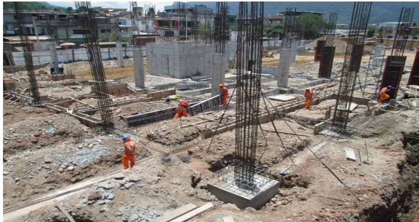
Imagen 70 : Colocación de armaduras de acero en placas – caja de escalera sector 03.
