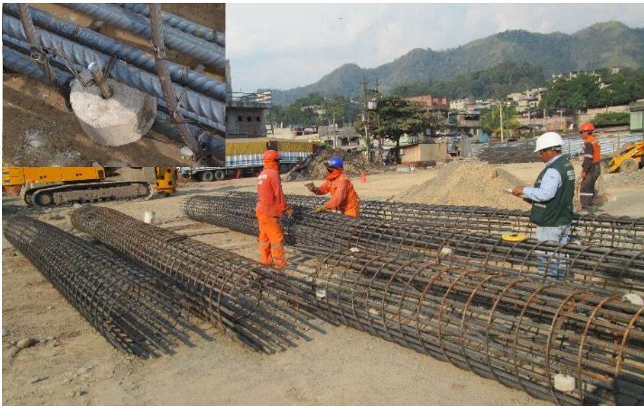
Imagen 56 : Instalación de separador para concreto en cada aro de rigidez, aros y zetas
