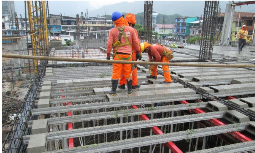
Imagen 86 : Vaciado – Losa Sector 2, piso3.
