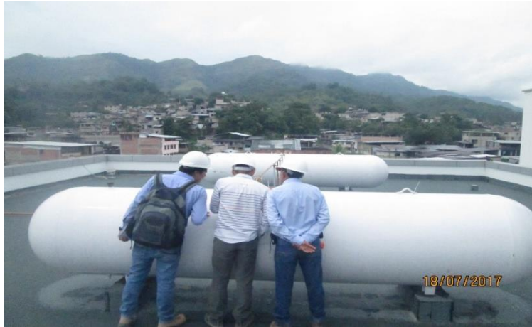
Imagen 168 : Equipos de Climatización
