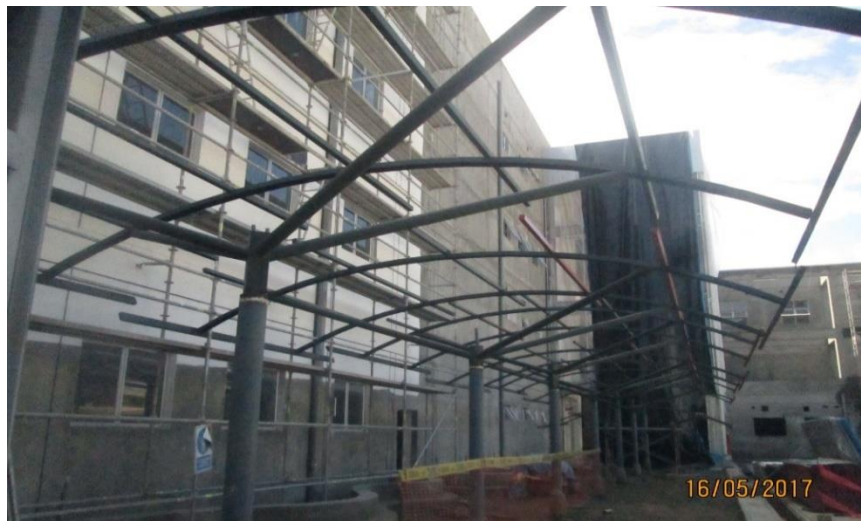
Imagen 102 : Estructuras metálicas – ingreso general.
