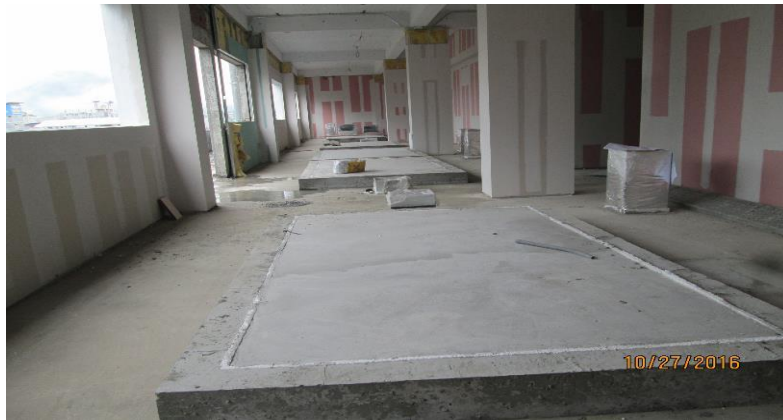
Imagen 122 : Pisos de concreto para base de CHILLERs y Bombas.
