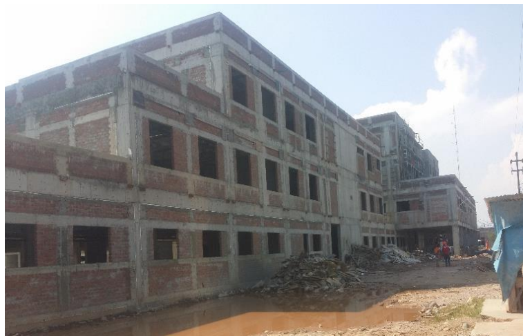
TARRAJEO DE MUROS INTERIOR Y EXTERIOR 1:5, e= 1.5 cm.
