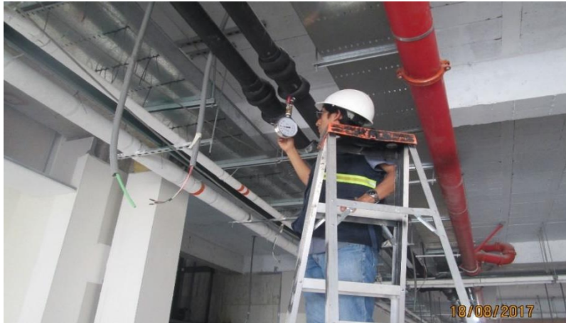
Imagen 188 : Pruebas hidráulica de la red de agua caliente, sector 02, nivel 01.
