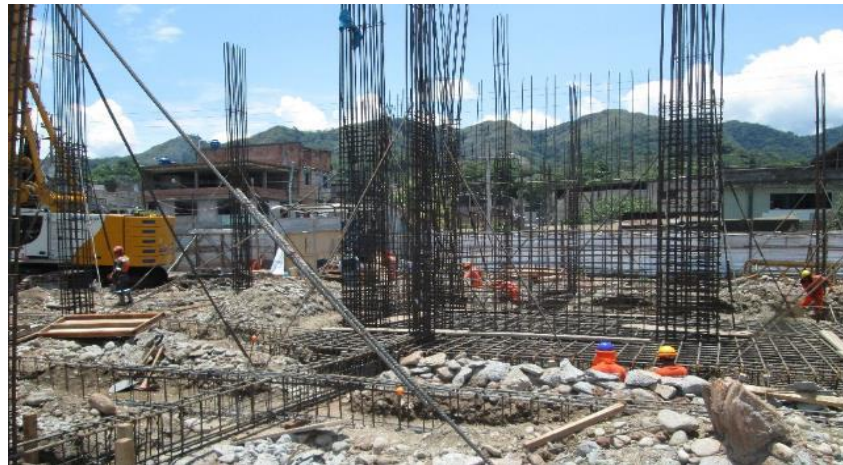
Imagen 68 : Colocación de armaduras de acero en placas – caja de escalera sector 03
