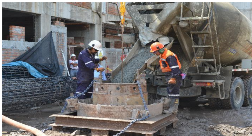
Imagen 62 : Guía y cono para controlar la caída de concreto.
