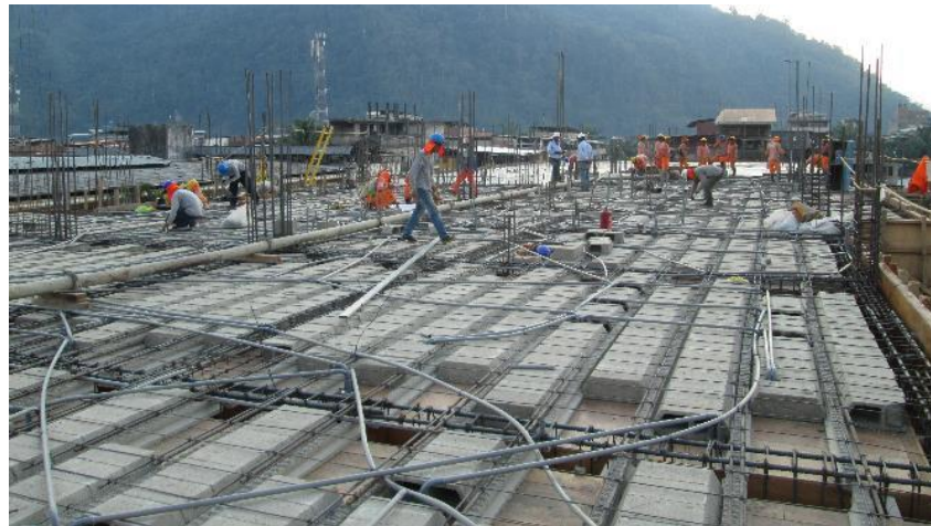
Imagen 87 : Bloquetas – Losa Sector 2.piso 4.
