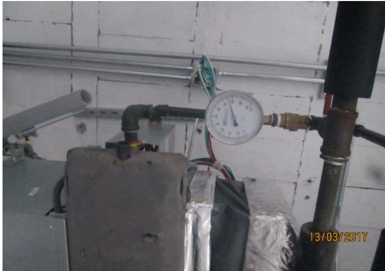
Imagen 171 : Pruebas de calidad drenaje fan coil.
