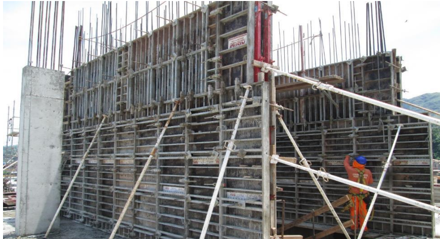
Imagen 75 : Encofrado Vigas S-4.
