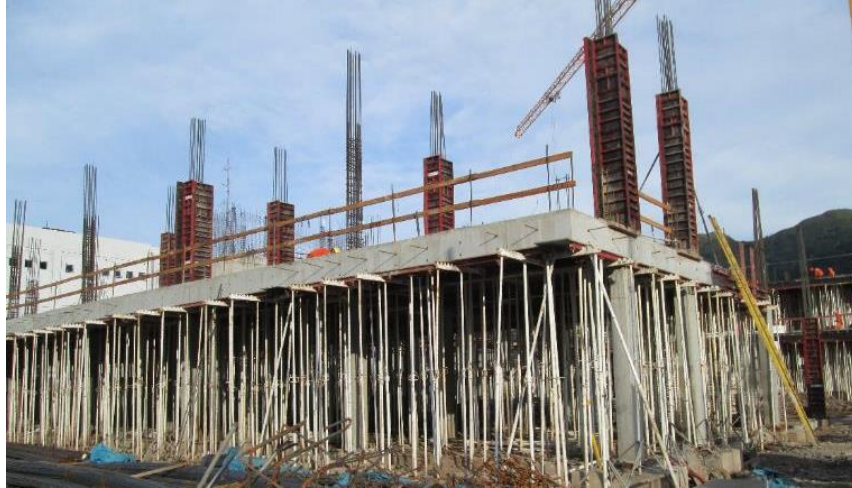
Imagen 80 : Encofrados losa y columnas S-2.
