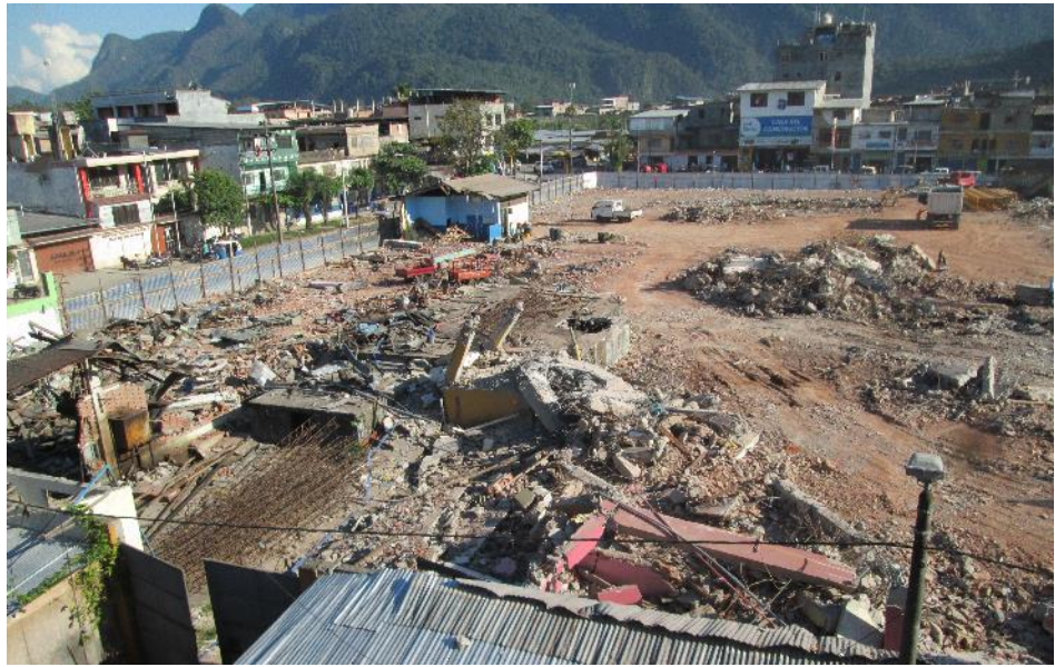
Imagen 40 : Demolición sector 01 y 03.
