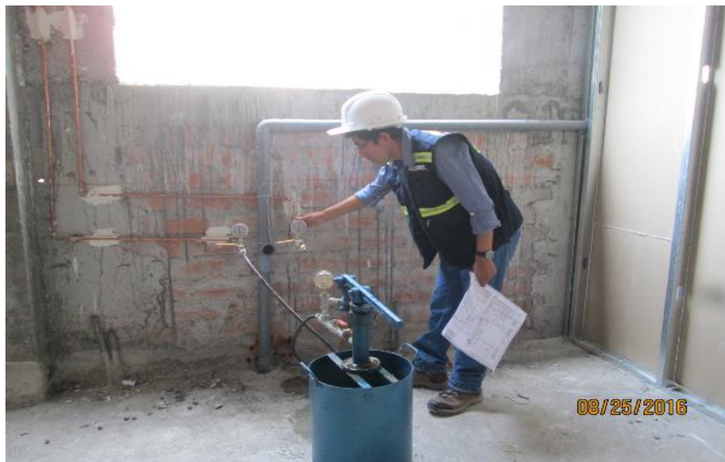
Imagen 188 : Pruebas hidráulica de la red de agua caliente, sector 02, nivel 01.
