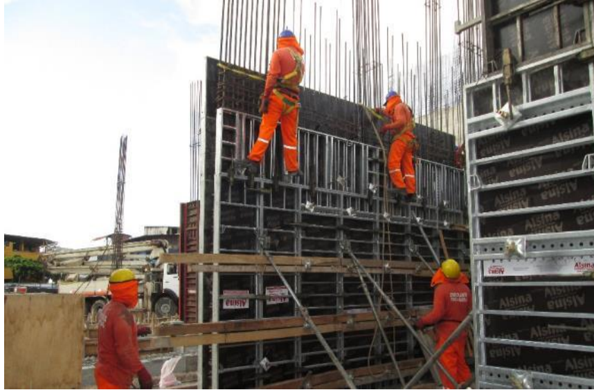
Imagen 74 : Encofrados placas S-04.
