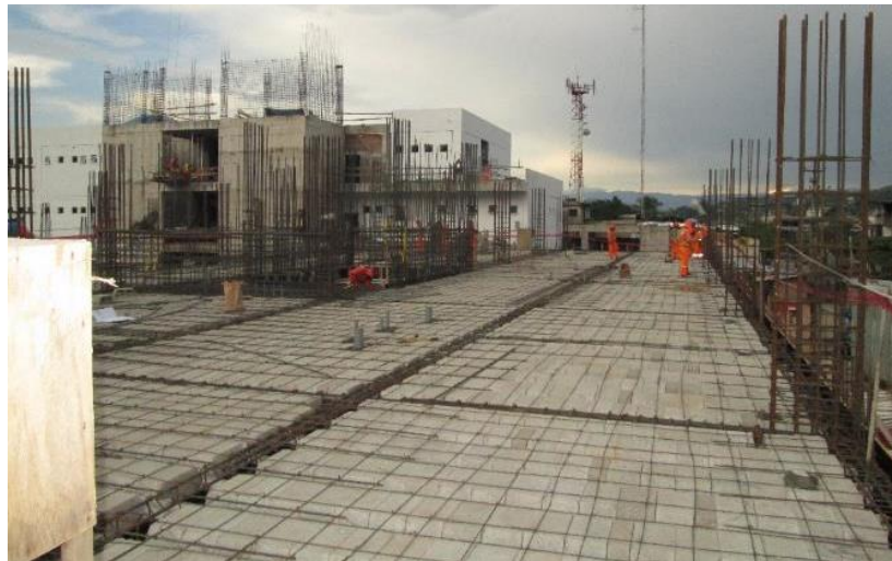
Imagen 83 : Colocación de acero e temperatura- piso 2, S-3.
