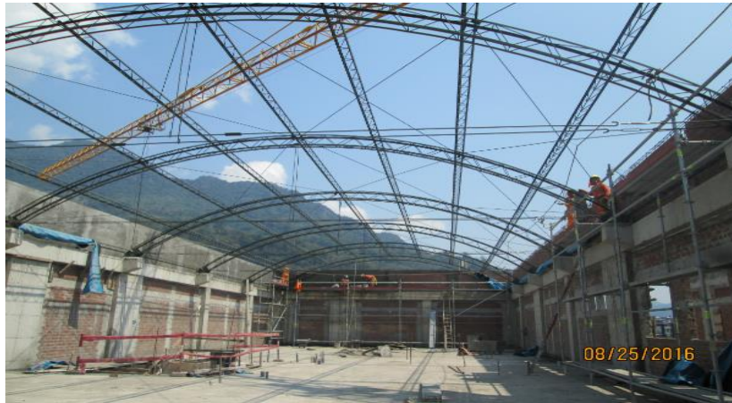
Imagen 101 : Techo parabólico – Auditorio.
