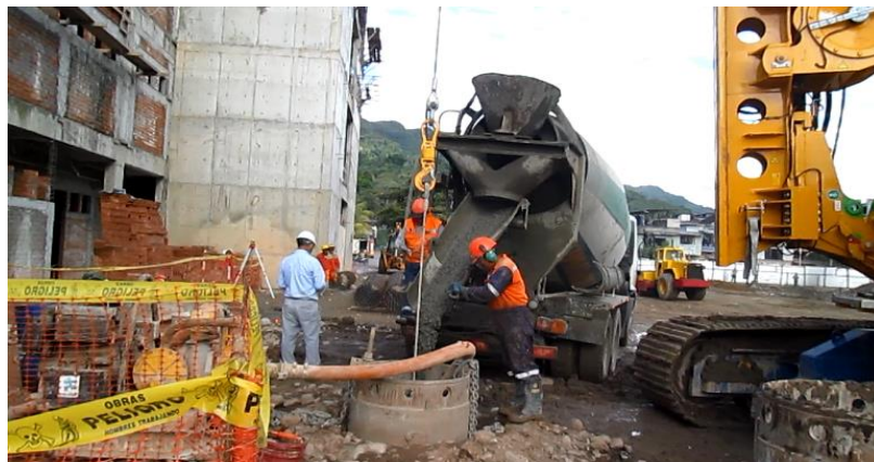
Imagen 60 : Colocación de concreto premezclado en pilotes. Sector 04.
