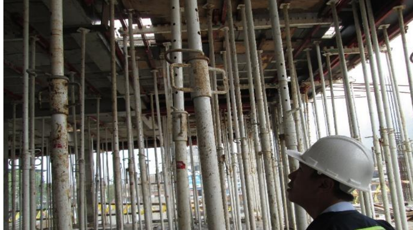
Imagen 77 : Encofrados de Vigas.
