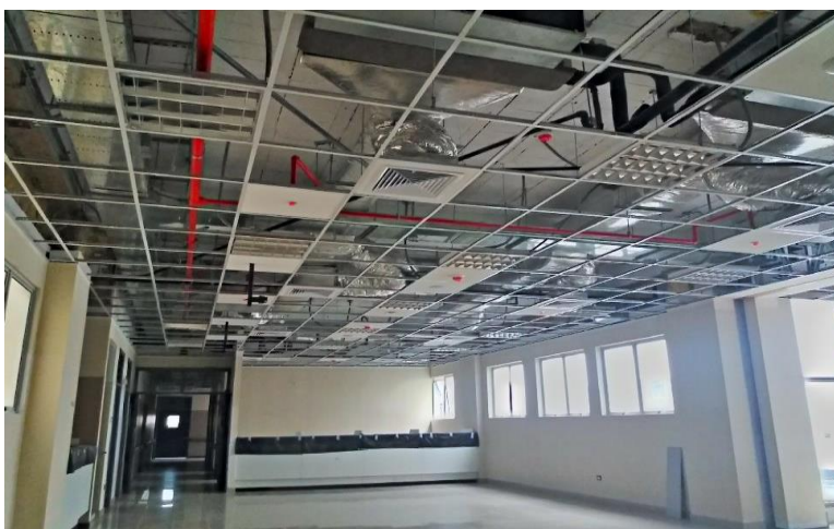
Imagen 154 : Pasadizo área hospitalización – sector 03, nivel 03.
