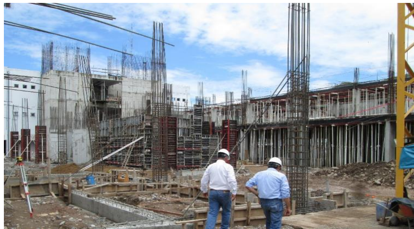
Imagen 80 : Encofrados losa y columnas S-2.
