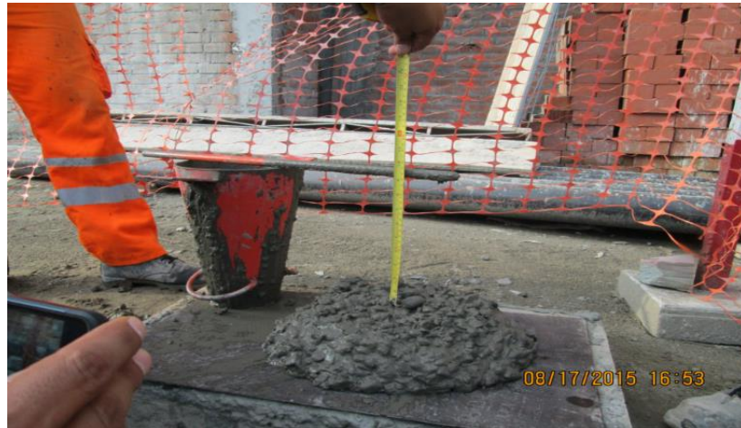
Imagen 59 : Determinación del SLUMP del concreto a colocar.
