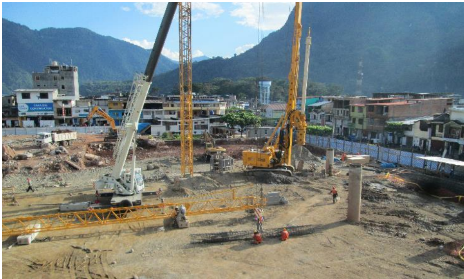
Imagen 52 : Introducción de entubación recuperable. Sector 01 y 02.
