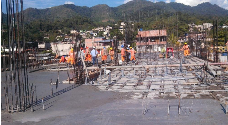
Imagen 92 : Instalaciones eléctricas y sanitarias en losa.
