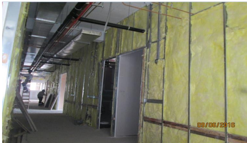
Imagen 136 : Tabiquería seca instalados en pasadizos área confort médico. Sector 2, nivel 02
