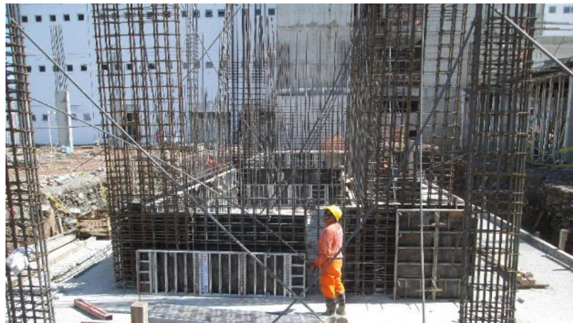
Imagen 69 : Colocación de armaduras de acero en placas – Columnas S-4
