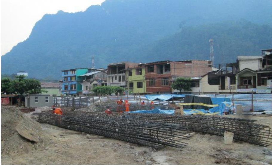
Imagen 56 : Instalación de separador para concreto en cada aro de rigidez, aros y zetas
