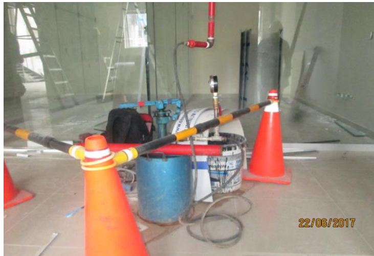
Imagen 194 : Lavadora vitrificada de 3 posas – SS-HH públicos.
