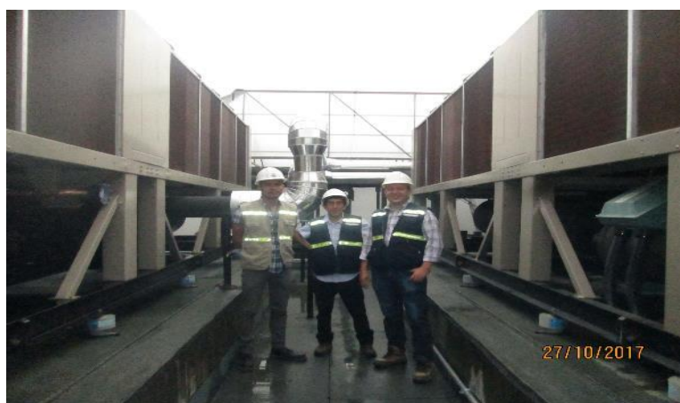
Imagen 182 : Instalación de paneles de Poliuretano – Cámaras Frigoríficas.
