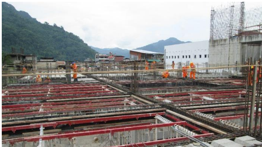
Imagen 78 : Colocación de soportes para losa
