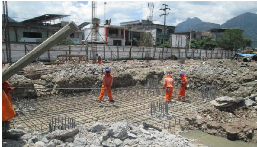
Imagen 64 : Instalación e armadura de acero en unión pilotes y cimentación.
