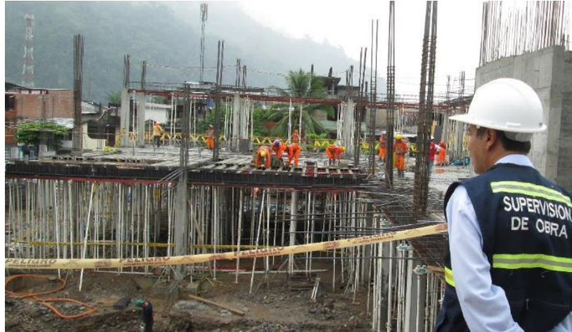
Imagen 83 : Colocación de acero e temperatura- piso 2, S-3.
