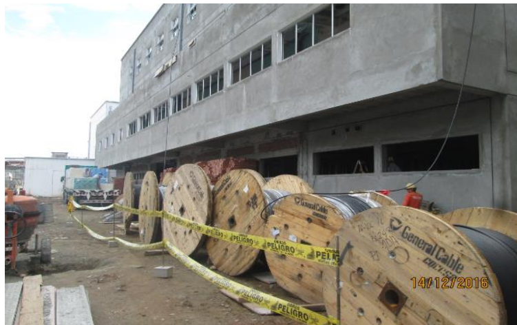
Imagen 204 : Cables de baja tensión para alimentadores
