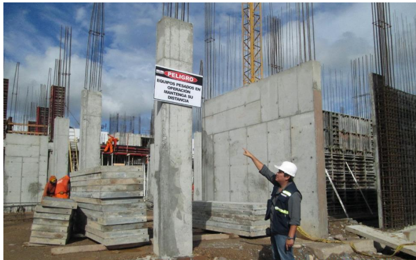
Imagen 84 : Placas y columnas S-02
