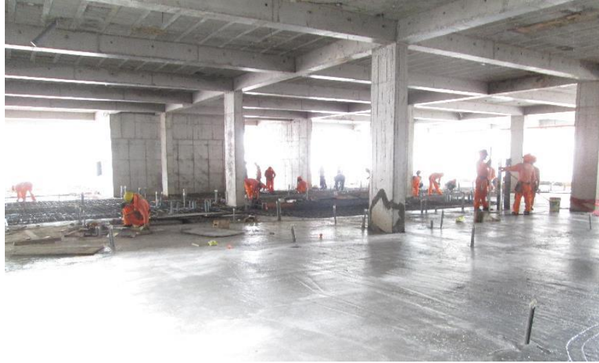
Imagen 119 : Contrapisos sector 03, nivel 03.
