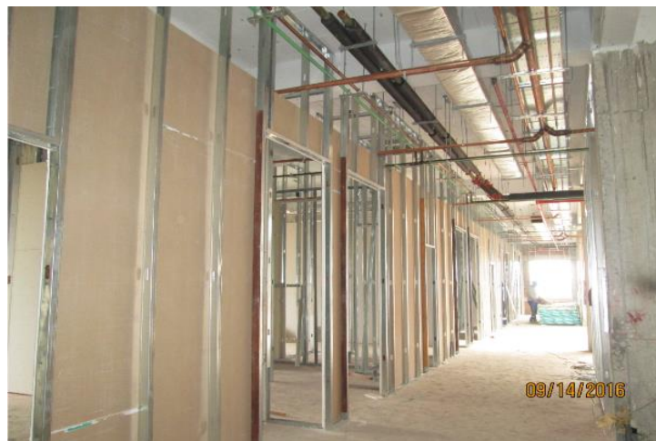
Imagen 192 : Redes de agua fría, caliente y helada. Sector 04, Nivel 02.
