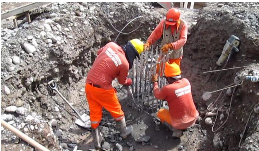
Imagen 63 : Descabezado de pilotes
