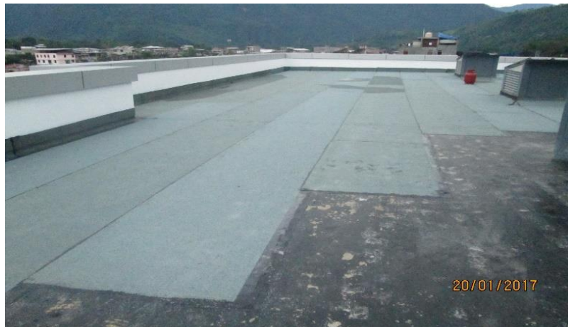
Imagen 151 : Colocación de manto impermeabilizante el azoteas.
