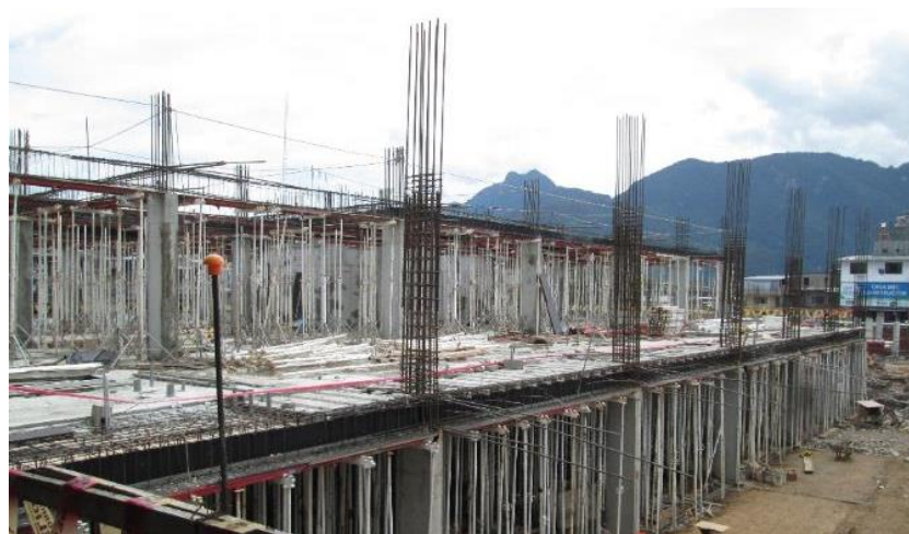
Imagen 82 : Colocación de soportes para losa S-4.
