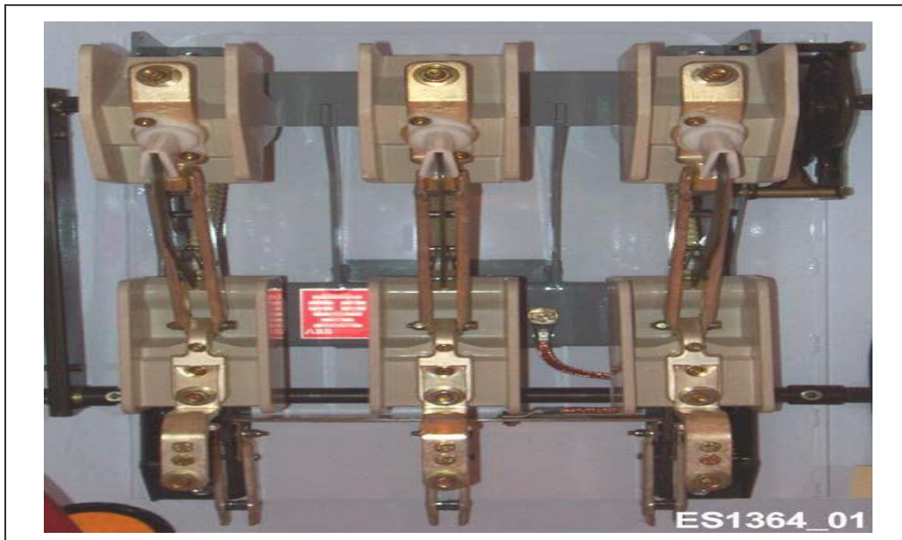
Figura 3-4: Interruptor de desconexión neumático con tierra
