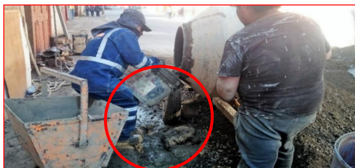
Figura 111: Mayor desperdicio en el momento de traspaso de mezcla a los baldes
