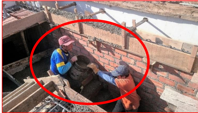
Figura 83: Personal optando por transportar la mezcla por medio de baldes
