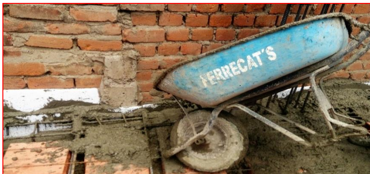
Figura 107: Tecnopor descolocado al momento de vaciar de la mezcla a causa de la falta de fijación
