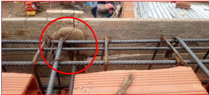
Figura 104: Mala práctica, uso de piedras para cuidar el recubrimiento mínimo
