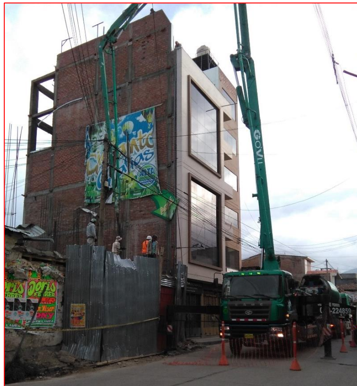
Figura 31: Vivienda N° 07– Vivienda Comercio
