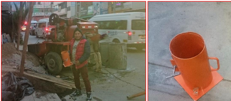
Figura 60: Colocado de los moldes sobre una superficie nivelada
