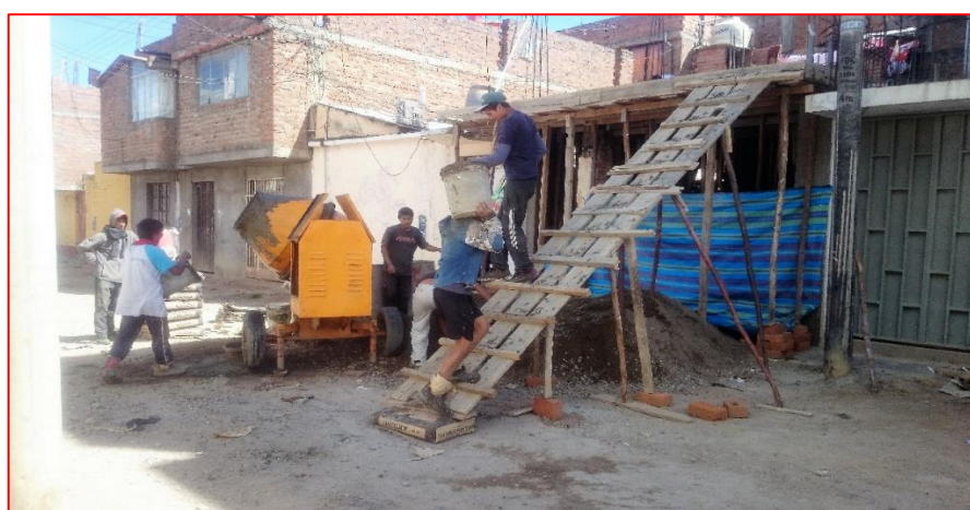
Figura 115: Transporte de concreto de forma manual (“lateros”)
