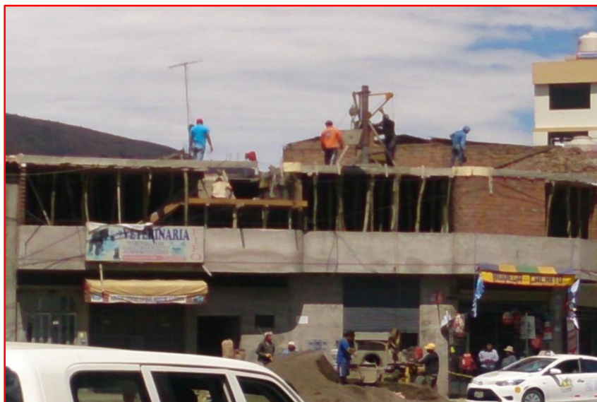
Figura 25: Vivienda N° 01 – Vivienda Comercio
