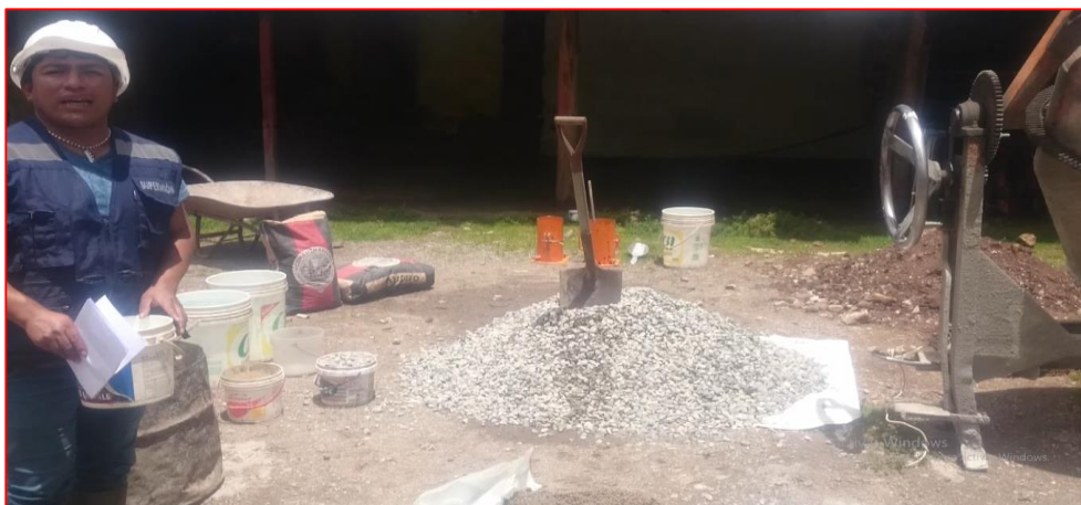
Figura 49: Elaboración de concreto con asesoría y supervisión de una persona con formación académica profesional de la especialidad
