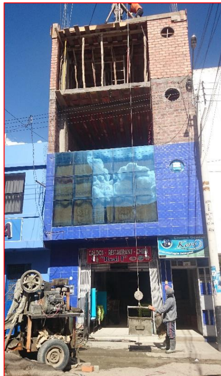
Figura 35: Vivienda N° 11 – Vivienda Comercio
