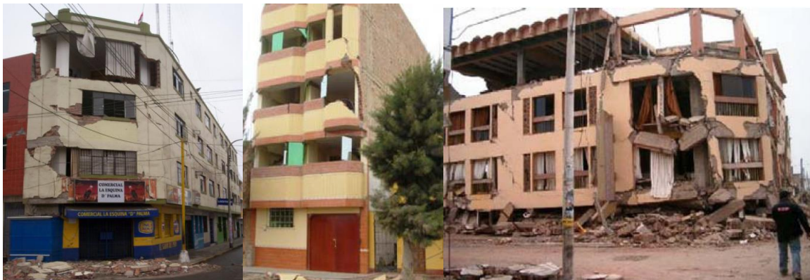
Figura 27: Daños en edificios de concreto armado y albañilería ante el sismo de Ica-2007
