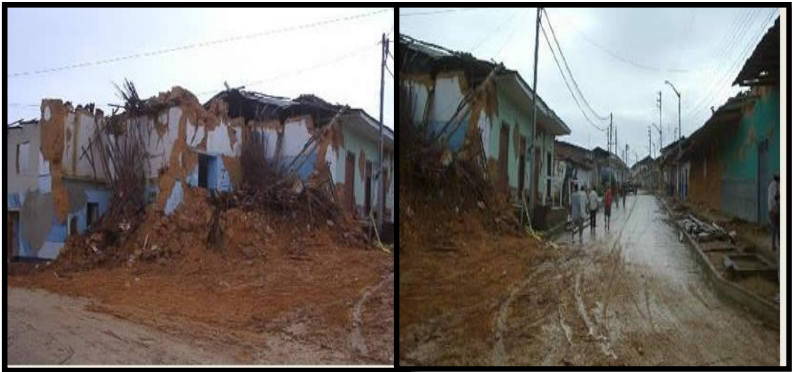
Figura 2: Edificación de adobe, colapsada en el evento de sismo de San Martín
