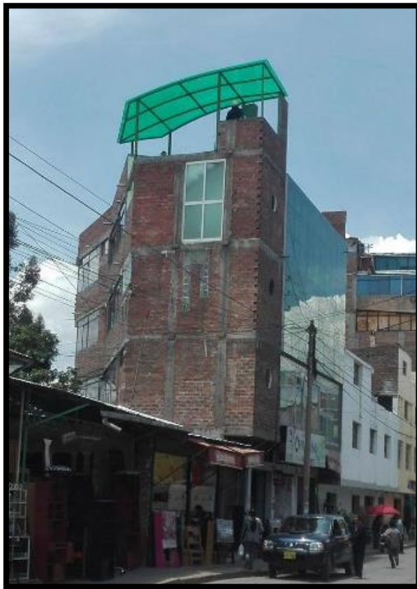
Figura 5: Edificio de 4 pisos, ubicado en el distrito de Chilca.
