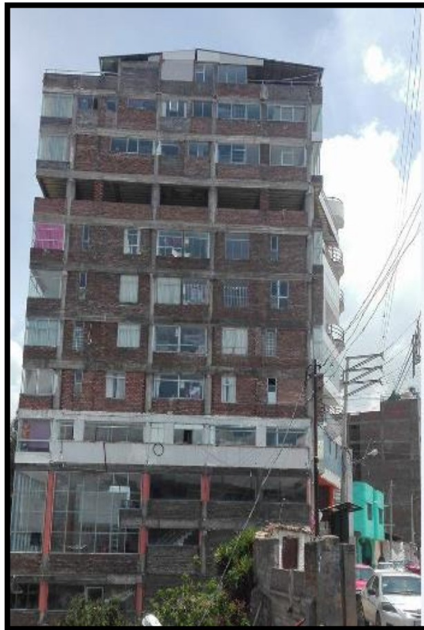
Figura 4: Edificio esbelto de 10 pisos ubicado en el distrito de El Tambo.
