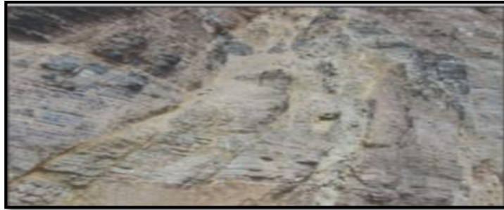
Figura N° 13: Zonas de corte en el macizo rocoso.
