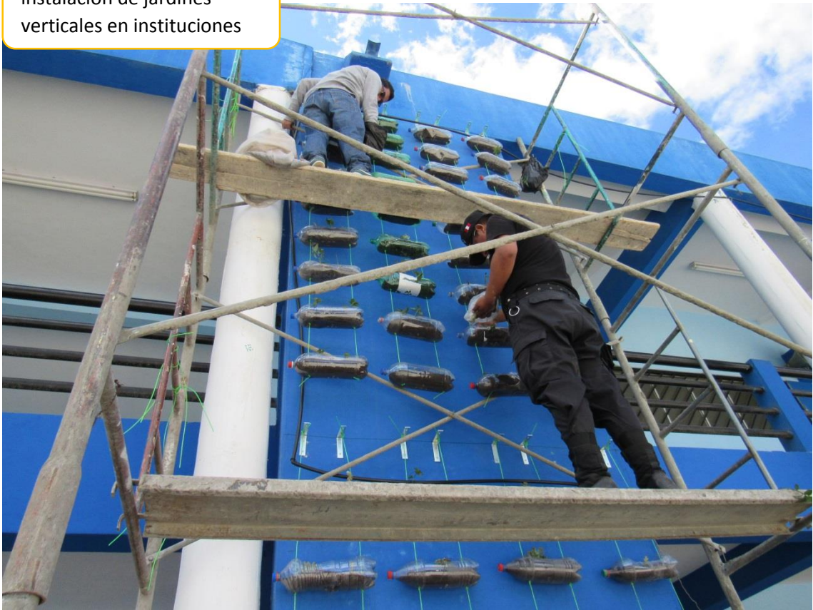
instalación de jardines verticales en instituciones
