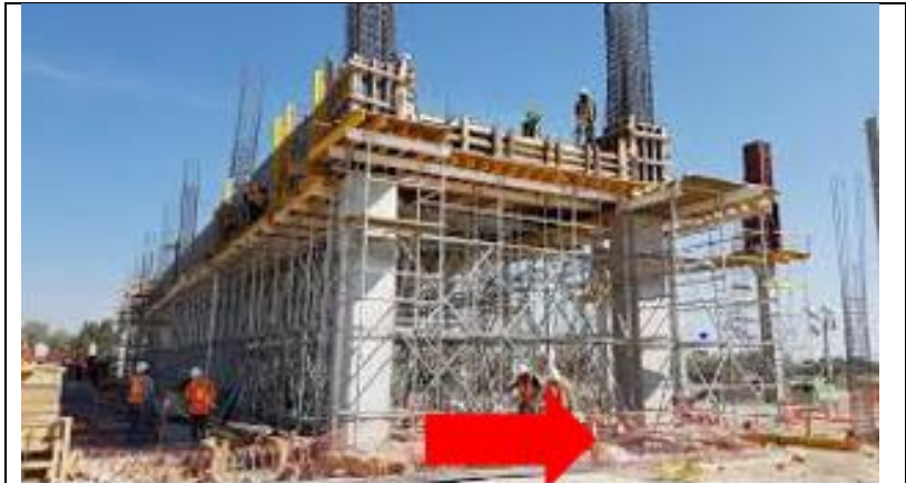
Figura N° 7: Sistema de encofrado con desplazamiento horizontal
