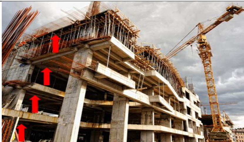
Figura N° 3: Sistema de encofrado tradicional
