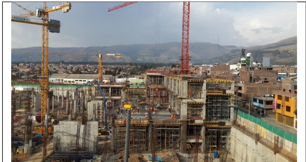
Figura N° 9: Planteamiento con un sistema de encofrados con desplazamiento horizontal.
