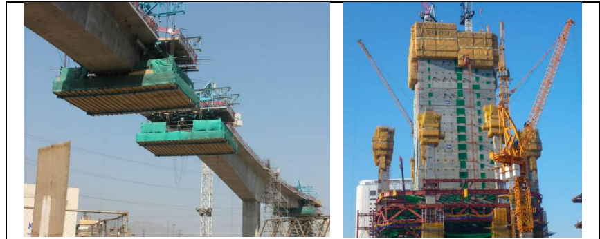
Figura N° 5: Sistema de encofrado deslizante
