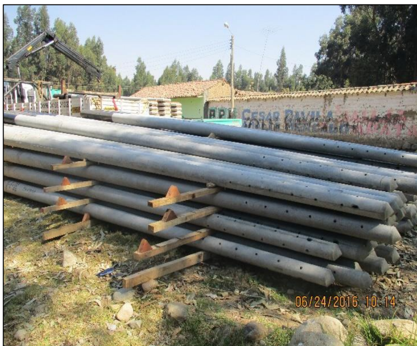
Figura: 12 Almacenamiento de postes de 9/300
