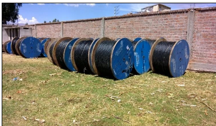
Figura: 14: Almacenamiento de Conductor Autoportantes tipo CAAI
