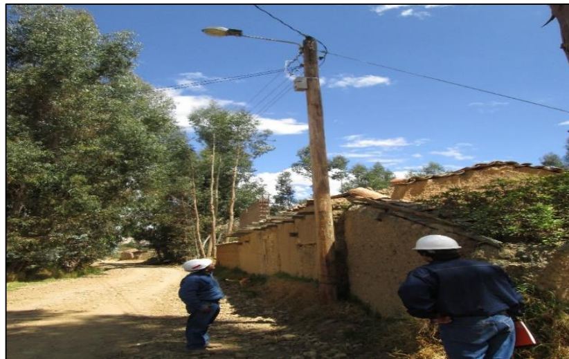
Figura 24: Actividad de replanteo Fuente: Elaboración propia
