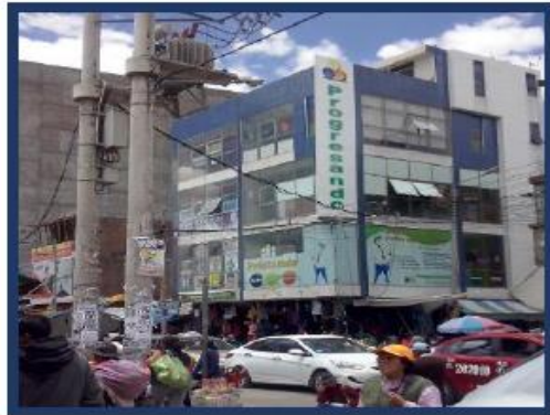
OFICINA PRINCIPAL EN EL DISTRITO DE HUANCAYO
