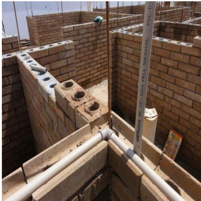
Figura 49: Detalle constructivo instalaciones sanitarias
