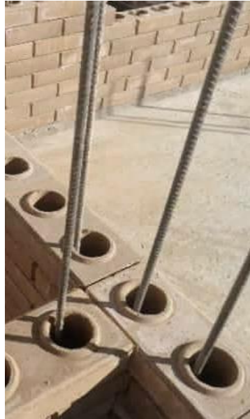
Fotografía 16: Acero de refuerzo en muros
