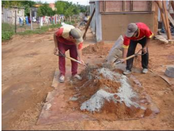
Figura 8: Preparación de la mezcla
