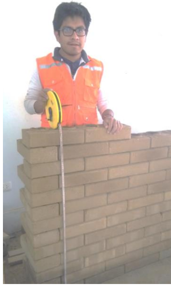
Fotografía 24: Armado de muro de saga de BTC
