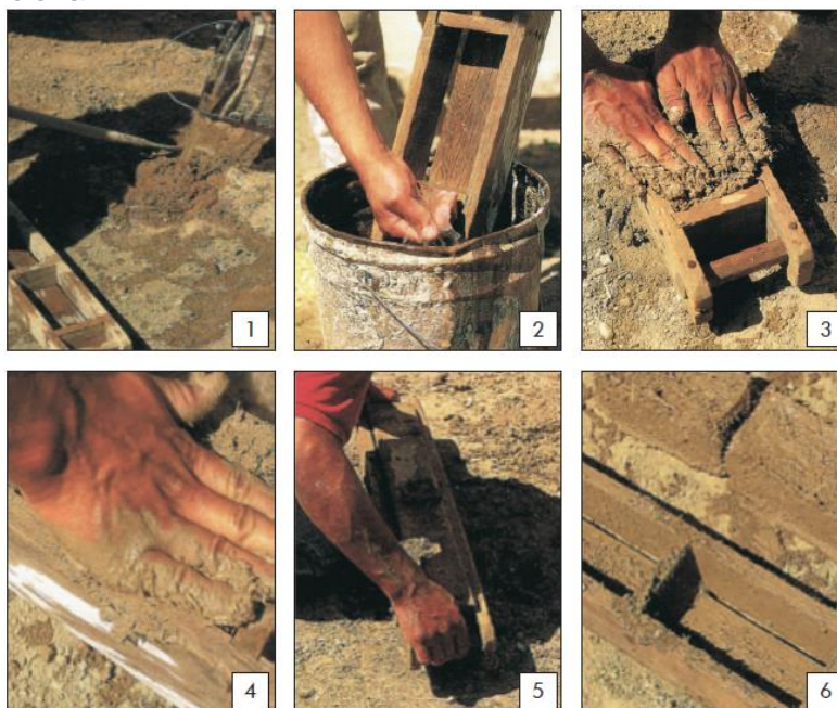
IMÁGENES B-2: Fabricación de adobes tradicionales. 1 Elaboración de la mezcla, 2 Lavado del molde, 3 Rellenar el molde previamente espolvoreado con arena fina para facilitar el desmolde, 4 Retirar el exceso de material, 5 Desmolde del adobe, 6 Secado.
