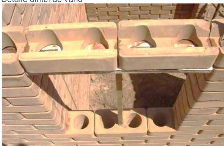
Fotografía 22: Detalle dintel de vano
