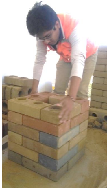
Fotografía 23: Armado de columna de BTC
