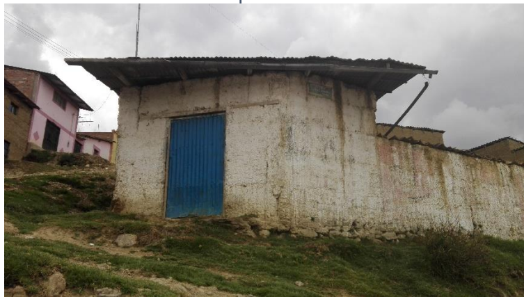
Fotografía 10: Vivienda construido con tapial
