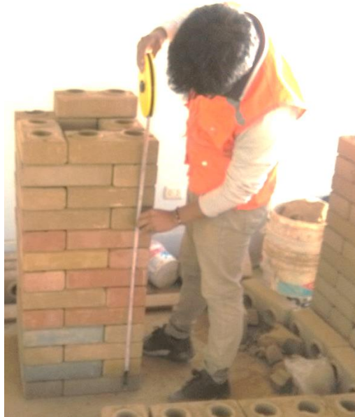
Fotografía 17: Simulación de construcción de columna
