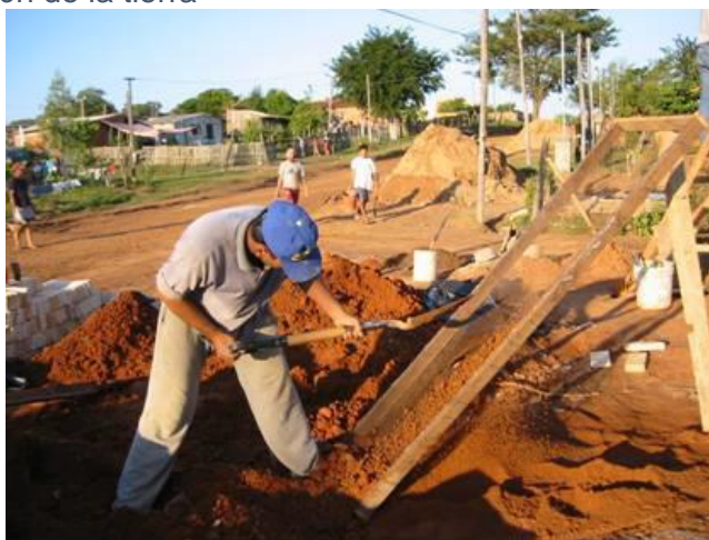
Figura 7: Preparación de la tierra
