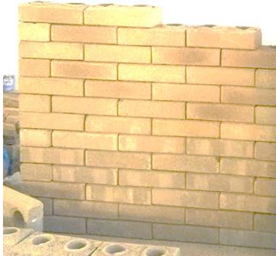
Fotografía 18: Detalle de muro de sogá con BTC
