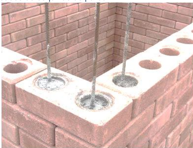
Fotografía 21: Vaceados de esquinas de pared
