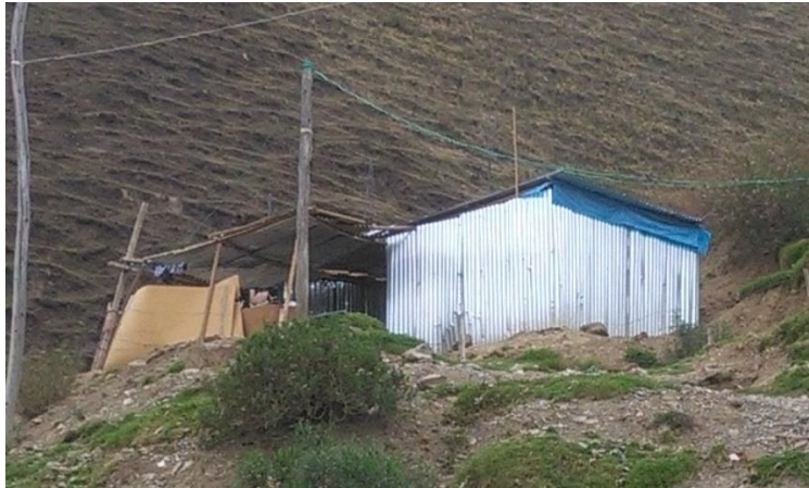
Fotografía 12: Vivienda construido con calamina
