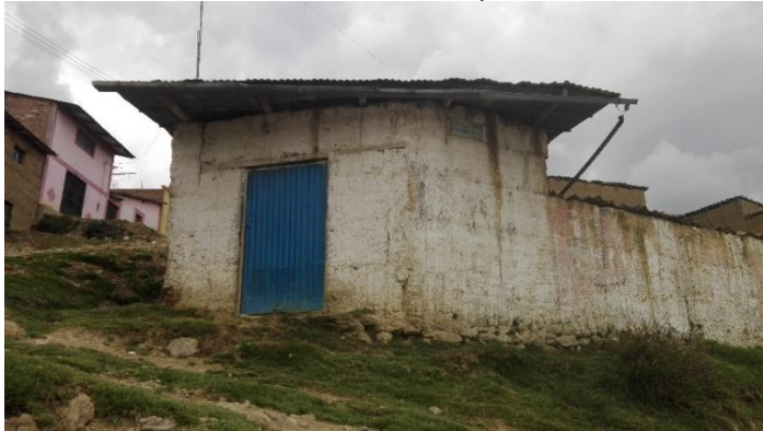
Fotografía 14: Vivienda en ladera con acabado de pintura
