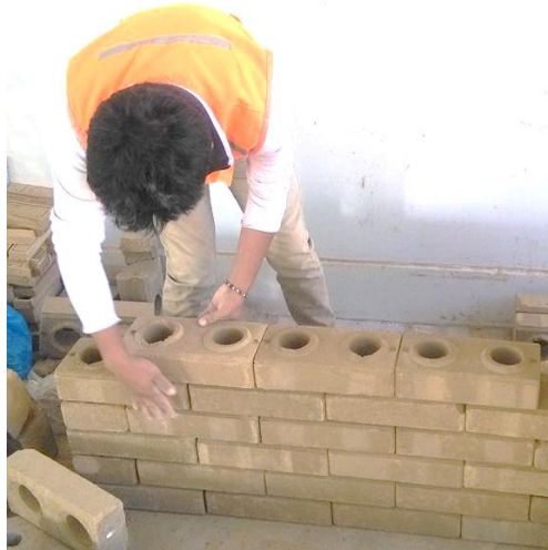
Fotografía 25: Armado de boque medio de BTC
