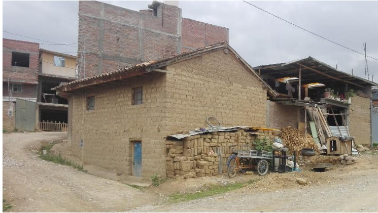
Fotografía 11: Vivienda construido con adobe
