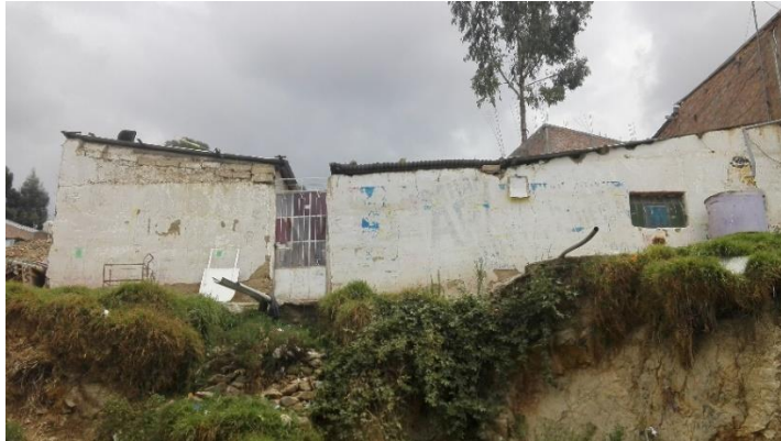
Fotografía 13: Vivienda en ladera con acabado en Yeso
