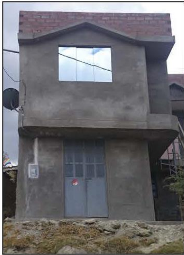
Vivienda de 2 niveles de material noble
