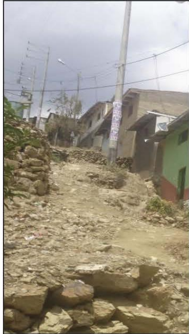
Escaleras en los pasajes para mejorar el transito peatonal.
