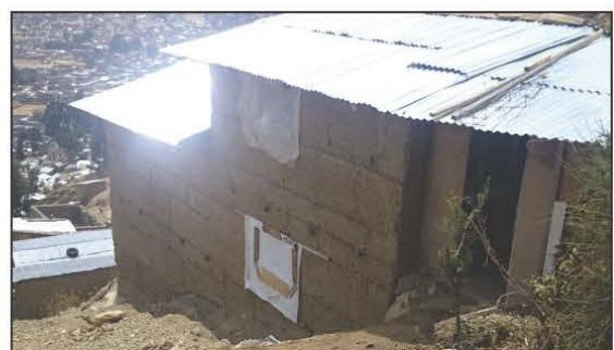
Vivienda en desnivel: Nótese el "sótano" que se produce por la gran diferencia de nivel con respecto a la pista
