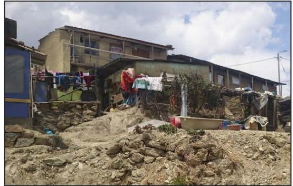
Los pobladores de esta zona han aprendido a usar los materiales que se encuentran disponibles, adaptandolos a los usos que necesiten: vivienda, muro de contención, cercos, veredas, escaleras, etc.
