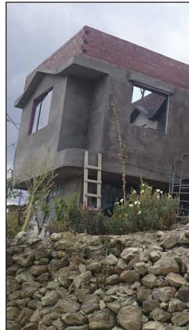
Muro de contención para vivienda unifamiliar de material noble.
