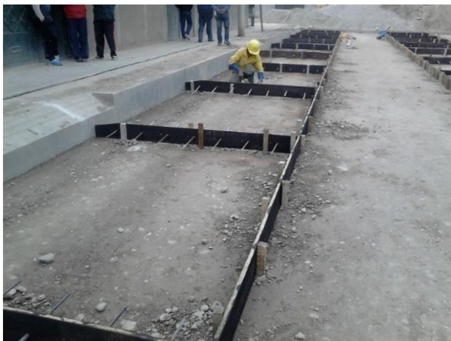
Imagen N° 4. Colocado de dowels en el encofrado
