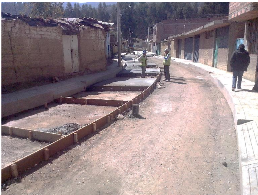
Imagen N° 7. Desencofrado de losa
