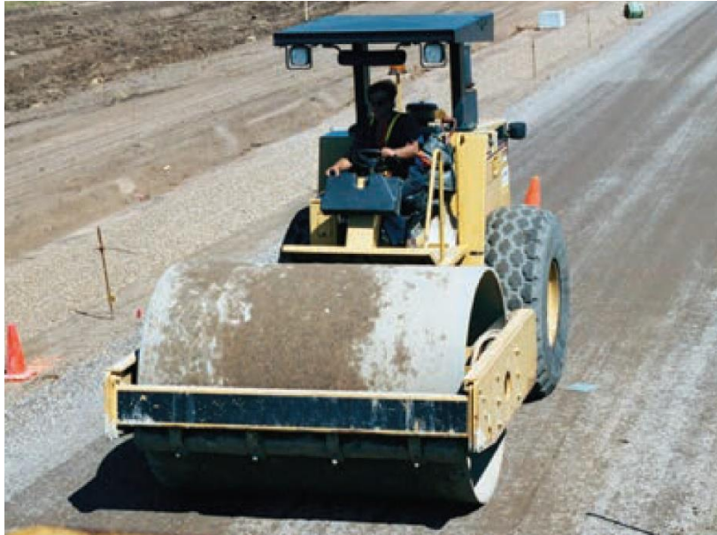
Imagen Nº 10. Compactado de la base del pavimento
