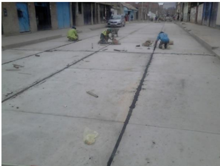
Imagen N° 8. Relleno de juntas
