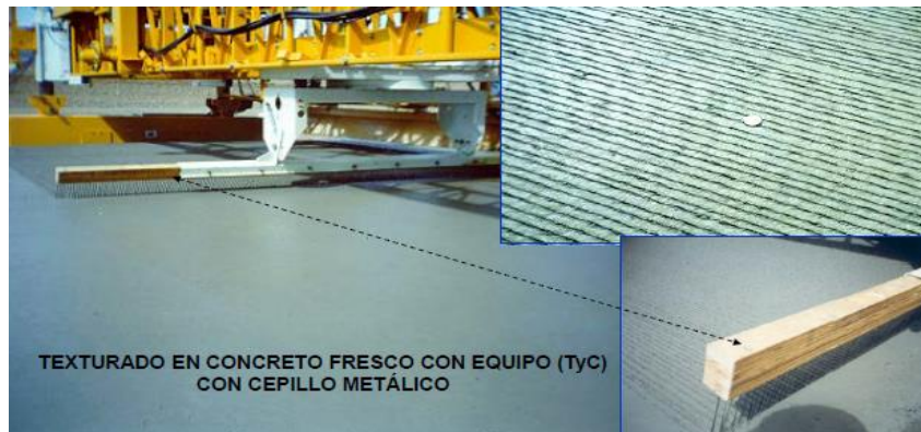
Imagen N° 22. Texturizado de la losa
