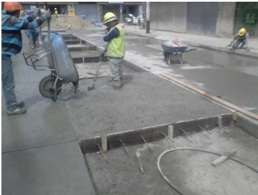
Imagen N° 5. Colocado del concreto en los paños de pavimento
