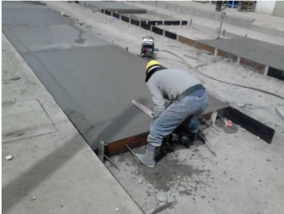
Imagen N° 6. Acabado de losa de concreto
